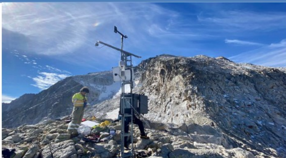
Estado actual de la Estación.
