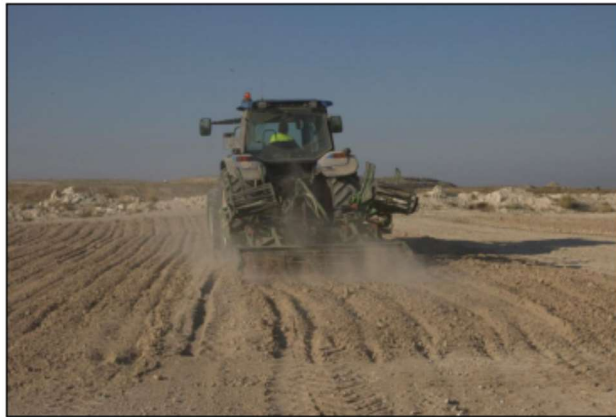
Maquinaria de arado homogeneizado el terreno.
