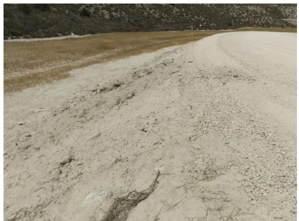
Taludes recrecidos del vial principal de acceso al PE, en el entorno de la SET: se ha añadido tierra vegetal.
