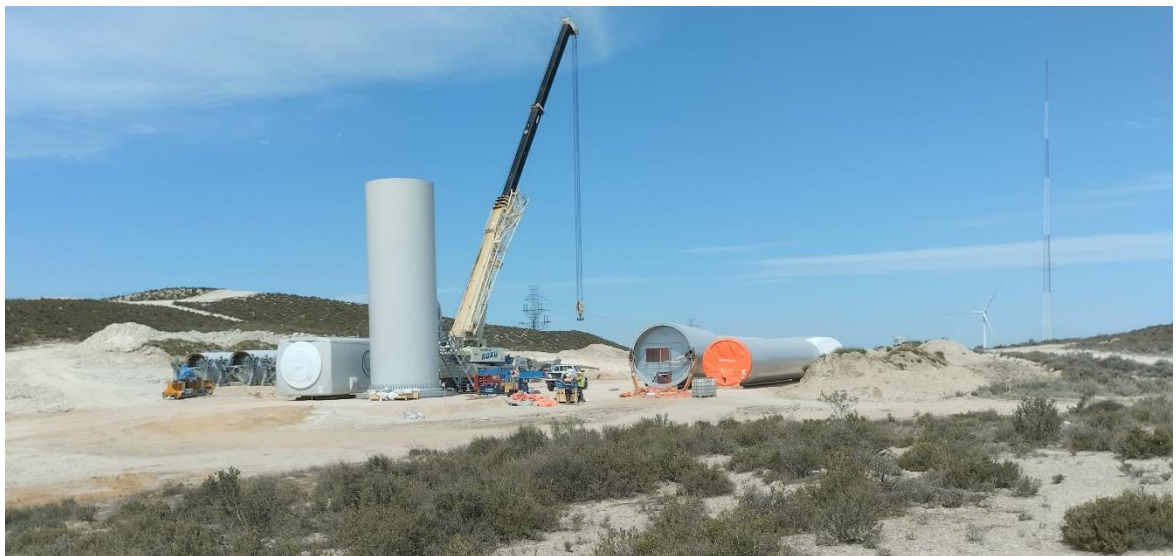
Plataforma del aerogenerador ACS 04, visto desde el sudeste. Montado el T1.
