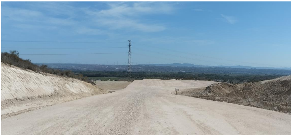
Plataforma del ACS 01, vista desde el sur.
