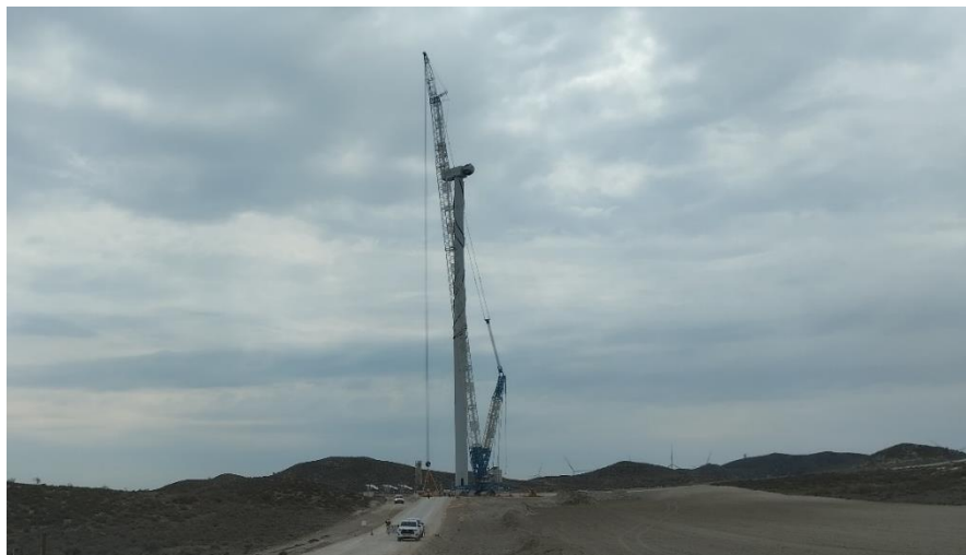
Plataforma del aerogenerador ACS 03, visto desde el oeste. Preparando el montaje de las palas.
