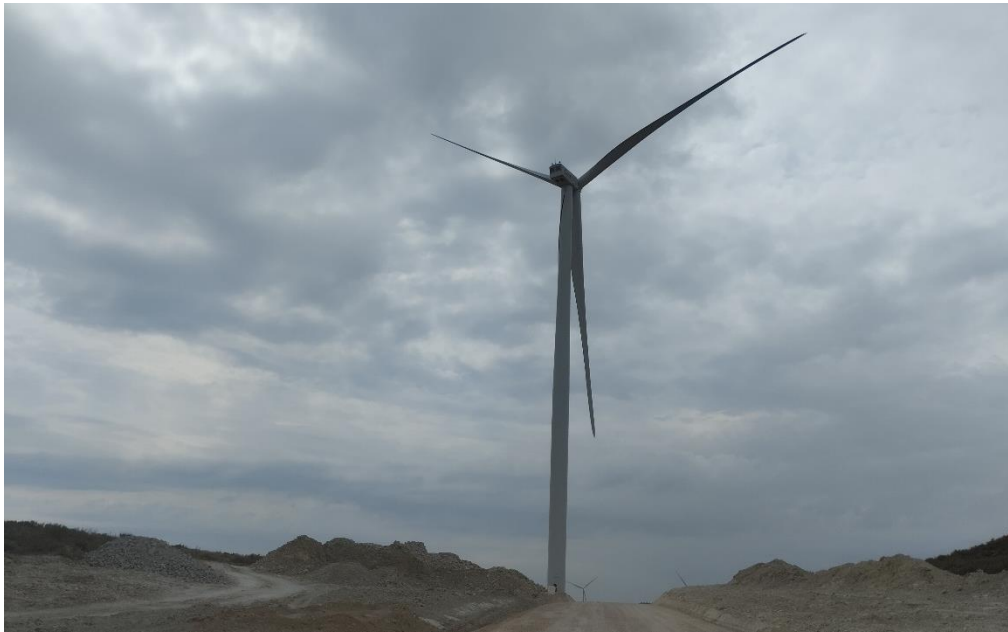
Aerogenerador ACS 04, visto desde el noroeste. Totalmente montado (22-05-23).
