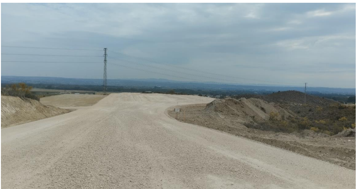
Plataforma del ACS 01, vista desde el sur.
