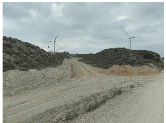
Izda., tramo de zanja tapado en la conexión con el aerogenerador ACS 05. Dcha., tramo aún sin tapar, en la conexión con la SET.
