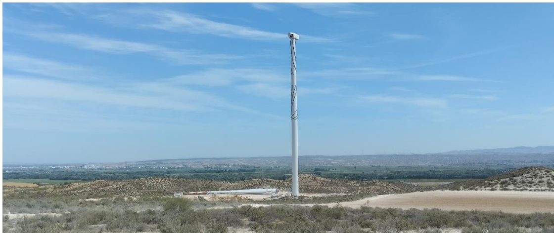
Plataforma del aerogenerador ACS 03, visto desde el sur. El montaje del aerogenerador se suspendió a falta de las palas, por avería de un útil de montaje. A la espera de su reparación, la grúa principal se desplazó al ACS 04, para su montaje.
