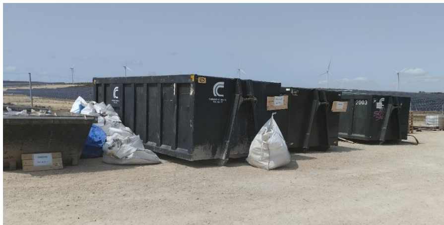
Punto limpio de RNP de SIEMSA: está programada la retirada las sacas con con envases del hormigón del grouting.
