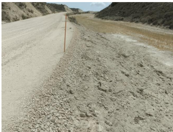
Taludes recrecidos del vial principal de acceso al PE, en el entorno de la SET: se ha añadido tierra vegetal.
