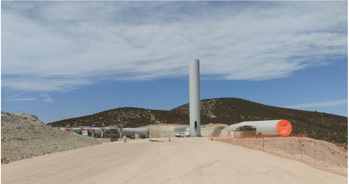
Plataforma del ACS 05. Ya montados T 1 y T 2.
