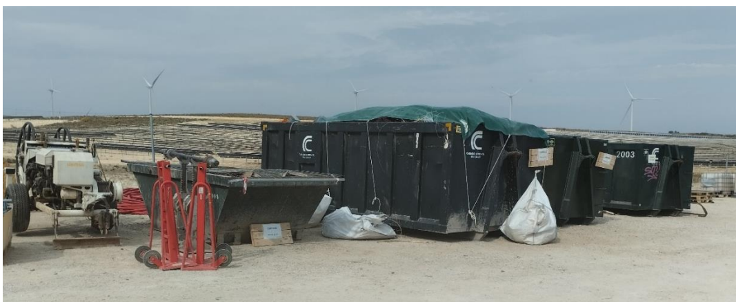
Punto limpio de RNP de SIEMSA: retiradas las sacas con con envases del hormigón del grouting (las que se aprecian en la fotografía tienen solo escombros, y se retirarán pronto).
