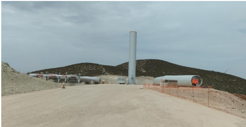
Plataforma del ACS 05. Montados T 1 y T 2.
