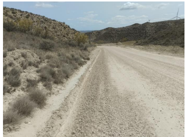
A la izda., balsa de limpieza de cubas próxima al ACS 05: desmanteladas y restaurados los terrenos. A la dcha., cunetas que fueron manchadas de hormigón, limpiadas y reperfiladas.
