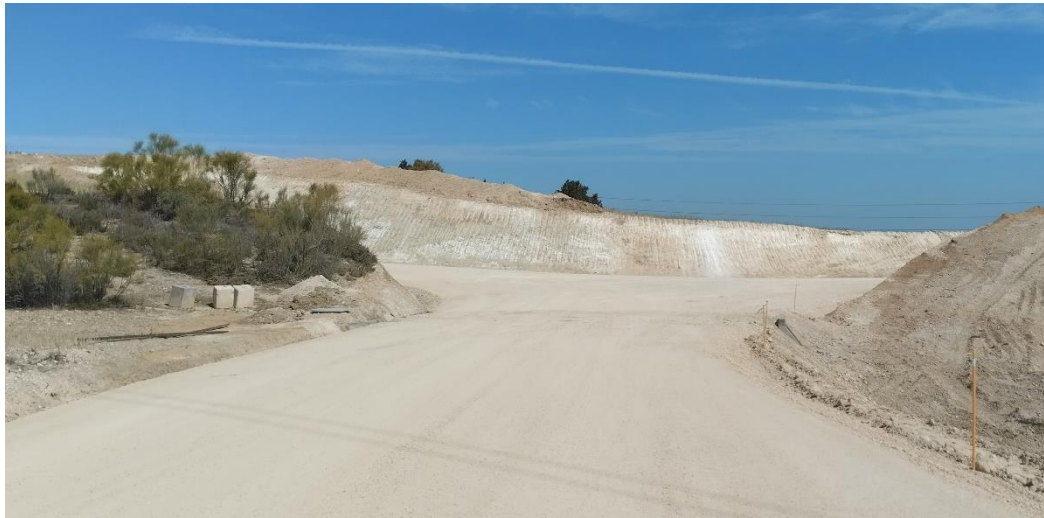
Acceso a la plataforma del ACS 01, y la zona de giro anexa (a la izda. de la fotografía), que será rellenada y restaurada.
