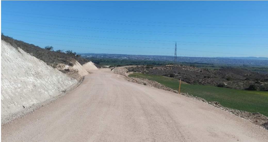
Vial de acceso al aerogenerador ACS 01, terminado a falta de remates. A la derecha, se distingue la zanja, ya tapada.
