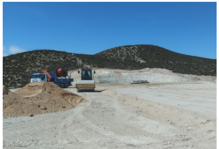
Izda., ejecución de una ODT, coincidiendo con la zona de giro próxima al ACS 05. Dcha., Plataforma del ACS 05, extendiendo zahorras
