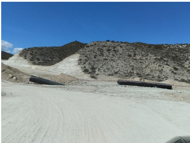
Izda., ejecución de una ODT, coincidiendo con la zona de giro próxima al ACS 05. Dcha., Plataforma del ACS 05, extendiendo zahorras
