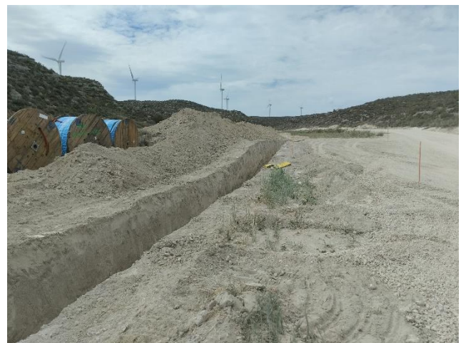
Tramos de zanja aún sin tapar. Izda., acceso al ACS 05. Dcha., acceso a la SET.
