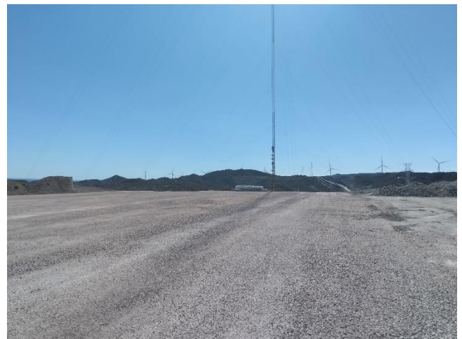
Izda, ACS 03. Dcha., ACS 04. zapatas tapadas y con zahorras extendidas en las superficies de servicio permanentes
