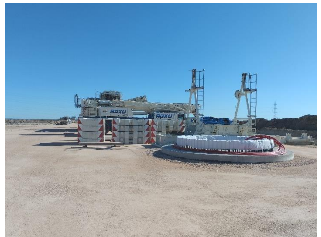
Izda., ACS 01. Dcha., ACS 02, ambas zapatas tapadas y plataformas con zahorras.
