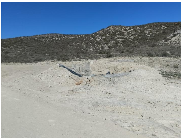
Balsa de limpieza de cubas del ACS 05, y cunetas contaminadas de hormigón, que deben ser limpiadas
