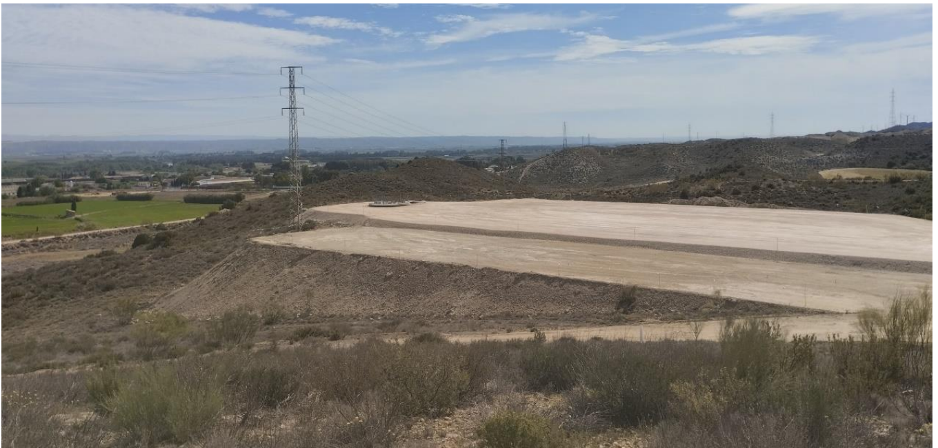
Plataforma del ACS 01, vista desde el oeste
