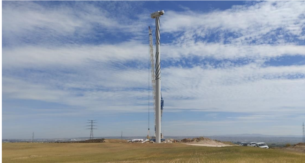
Plataforma del ACS 02 (montando el aerogenerador), vista desde el sur
