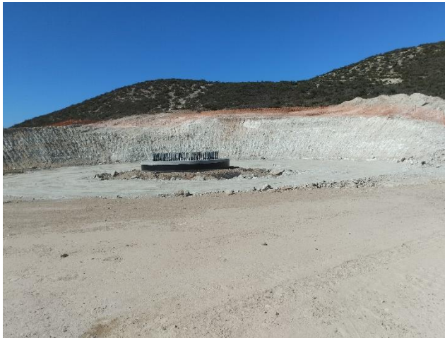
Izda., Plataforma del ACS 05: zapata tapada. Dcha., llegada de la zanja al ACS 05, pendiente de ejecutar
