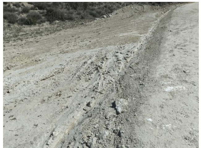
Balsa de limpieza de cubas del ACS 05, y cunetas contaminadas de hormigón, que deben ser limpiadas
