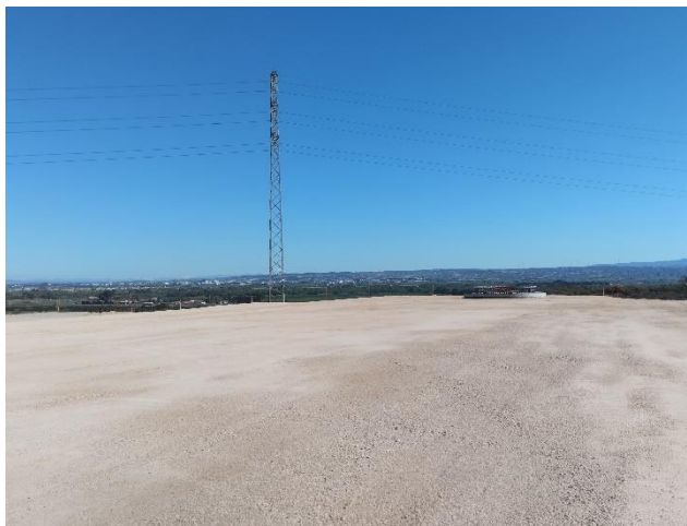
Izda., ACS 01. Dcha., ACS 02, ambas zapatas tapadas y plataformas con zahorras.
