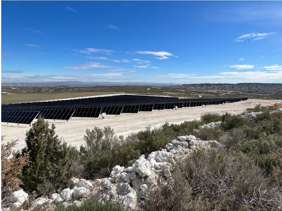
Figura 9 Montaje de los módulos fotovoltaicos
