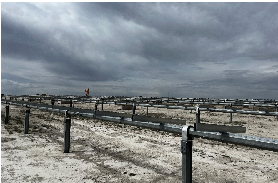
Figura 7 Montaje de los trackers
