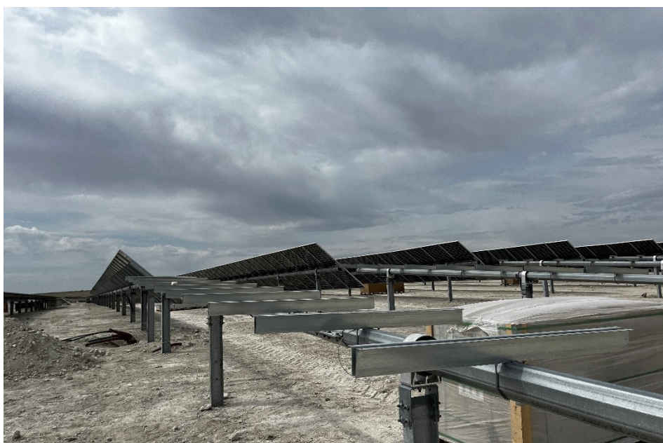
Figura 8 Montaje de los módulos
