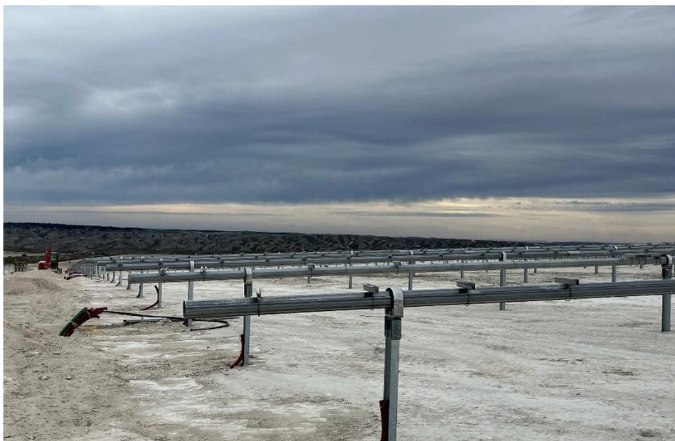
*Figura 7 Montaje de los trackers*
