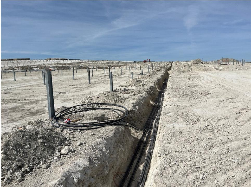
*Figura 9 Cableado de las zanjas*
