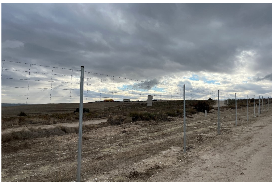
Figura 9 Colocación de las placas esteparias
