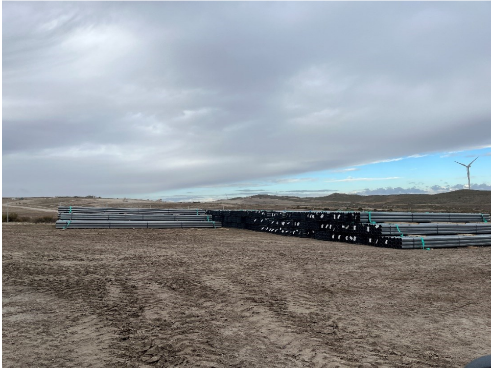
Figura 10 Zona de acopio de material de construcción
