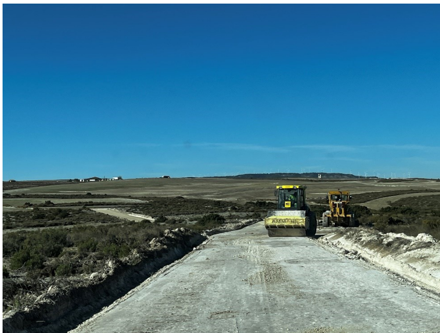
Figura 2 Trabajos de apertura de viales
