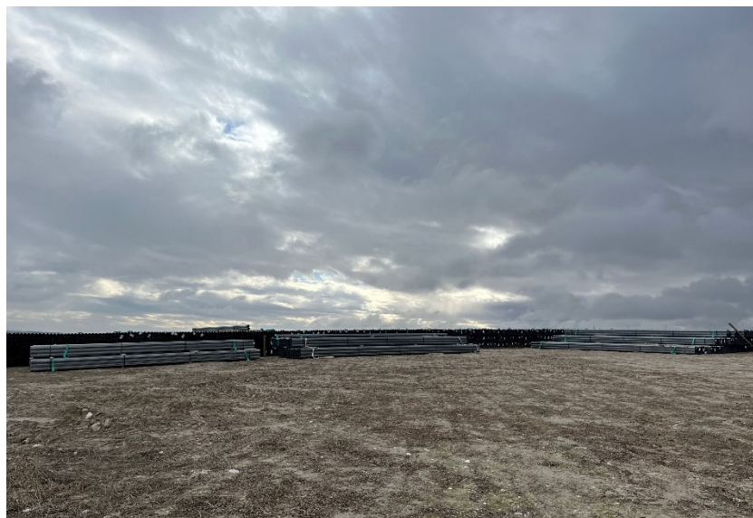
Figura 5 Acopio de material de construcción
