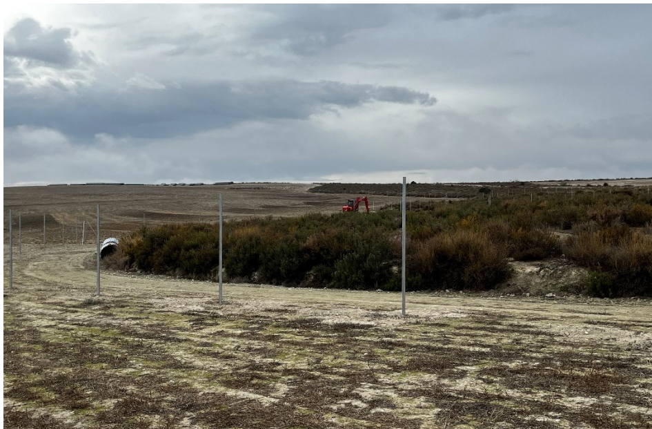
Figura 8 Instalación del vallado perimetral
