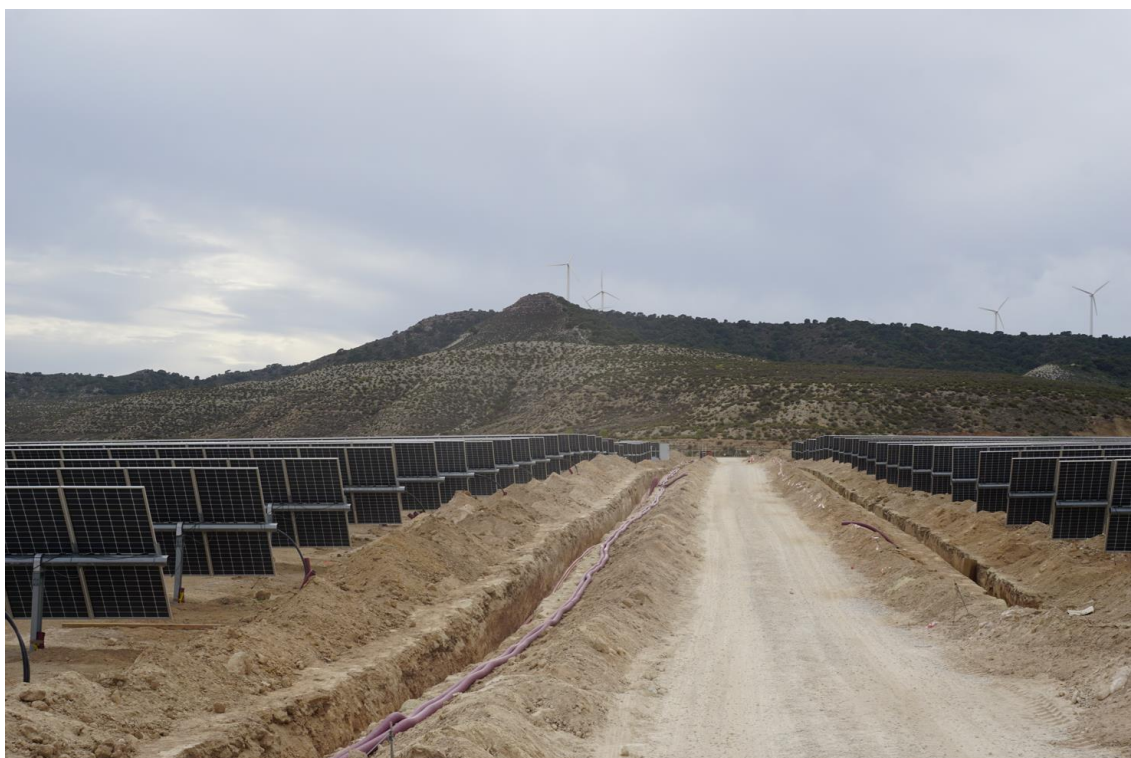
Figura 2a Zanjas para red eléctrica soterrada en Vallobar
