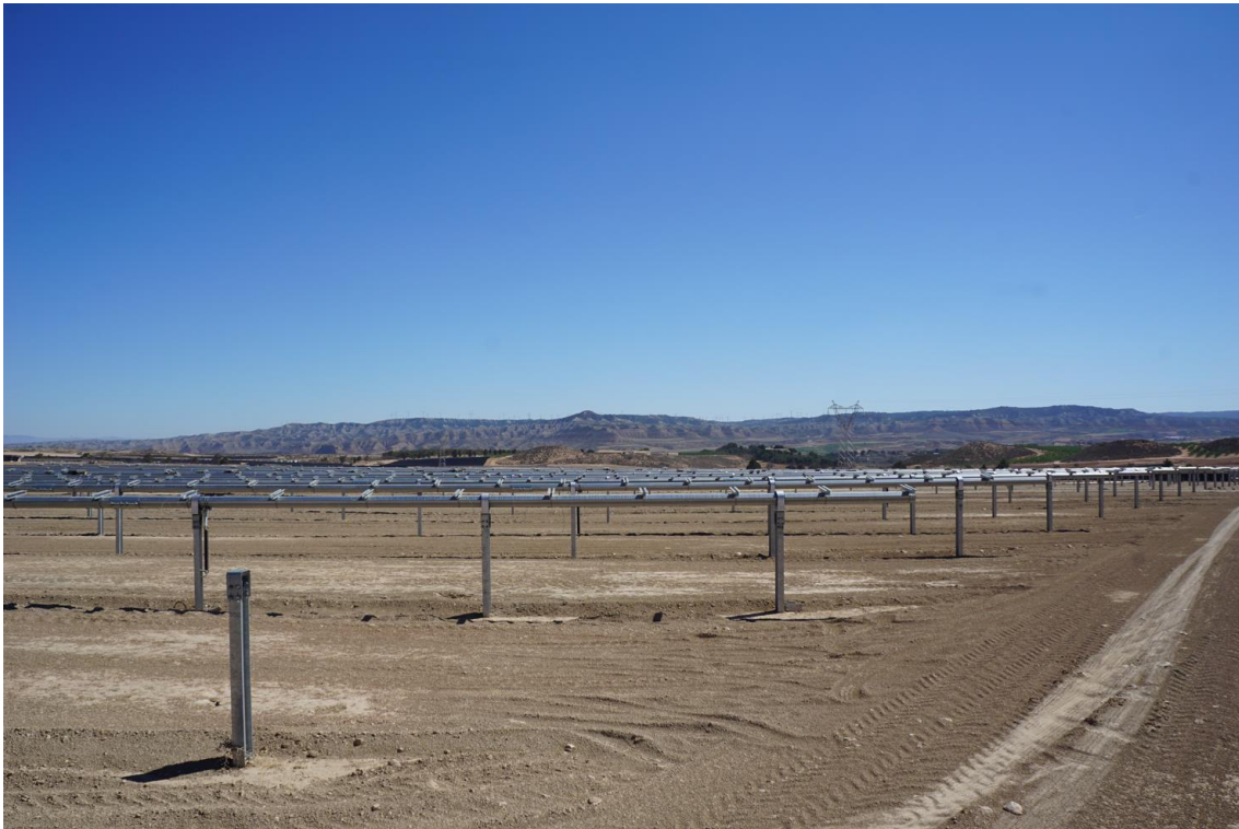
Figura 4 Seguidores preparados para la instalación de placas, zona oeste de Vallobar
