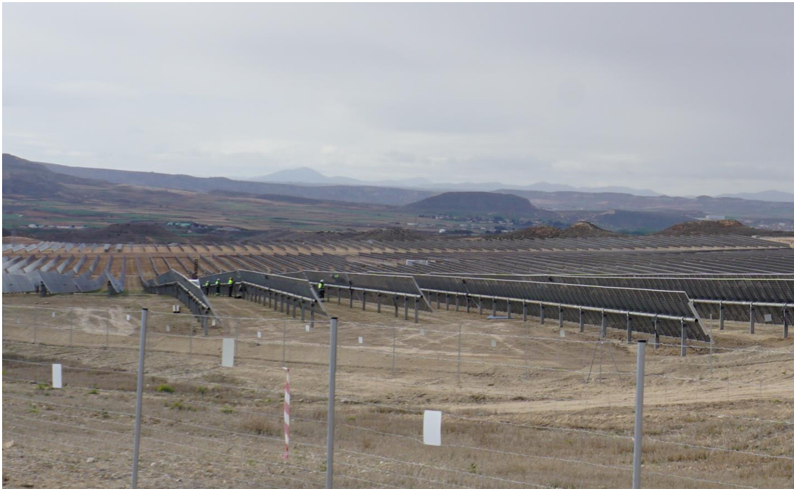
Figura 7 Operarios instalando placas fotovoltaicas en Vallobar
