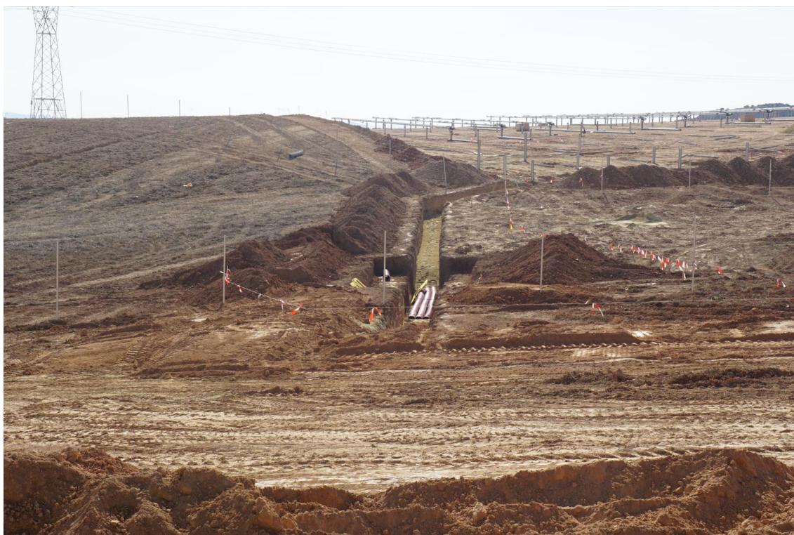
Figura 2a Zanja para soterrado de conexiones eléctricas internas de Vallobar
