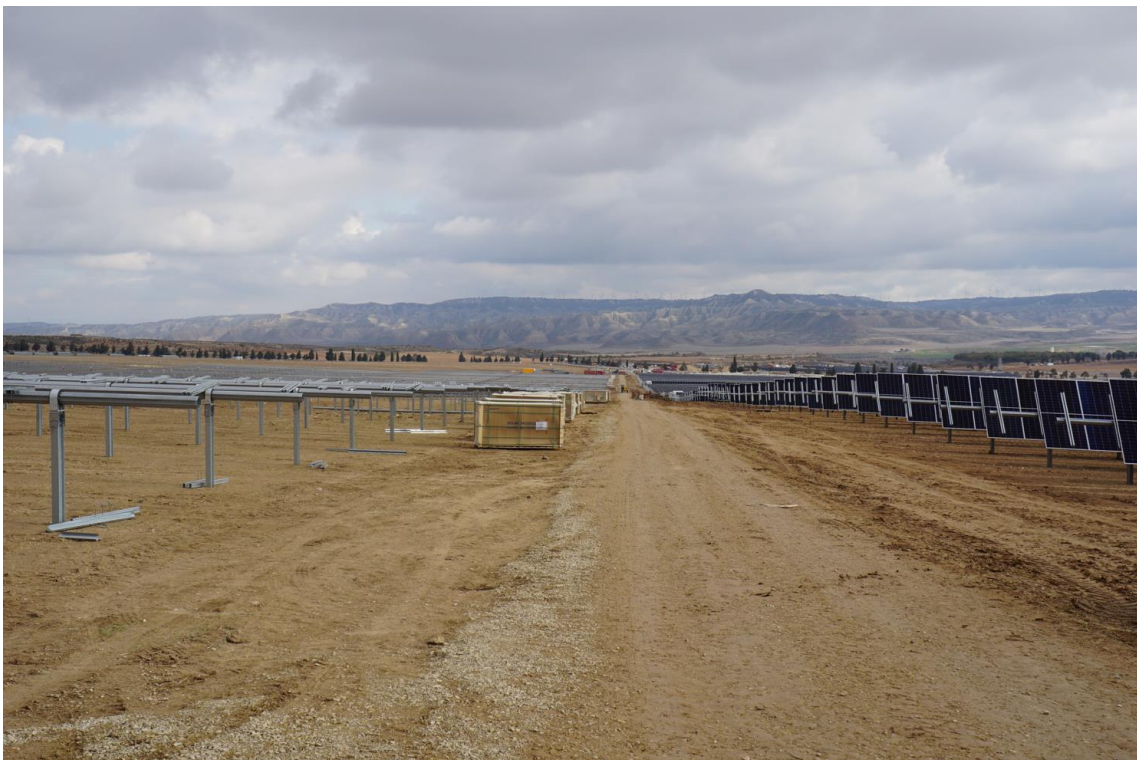
Figura 7 Avance de la instalación de placas fotovoltaicas
