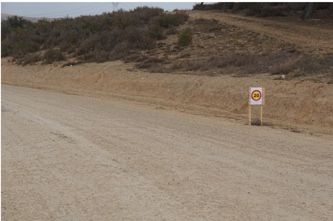
Figura 9 Señalización de límite de velocidad en obra
