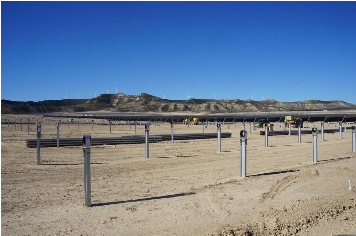
Figura 5 Instalación de seguidores
