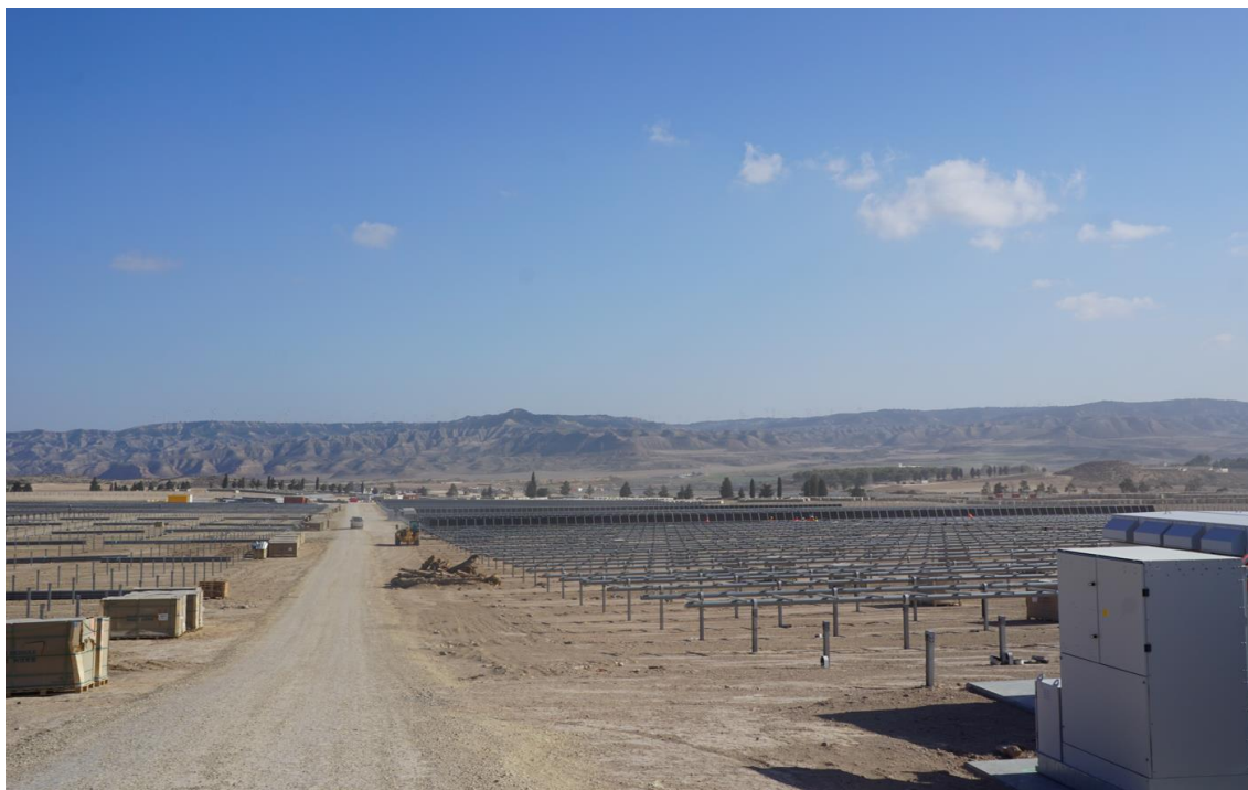
Figura 2b Instalación de seguidores y placas fotovoltaicas
