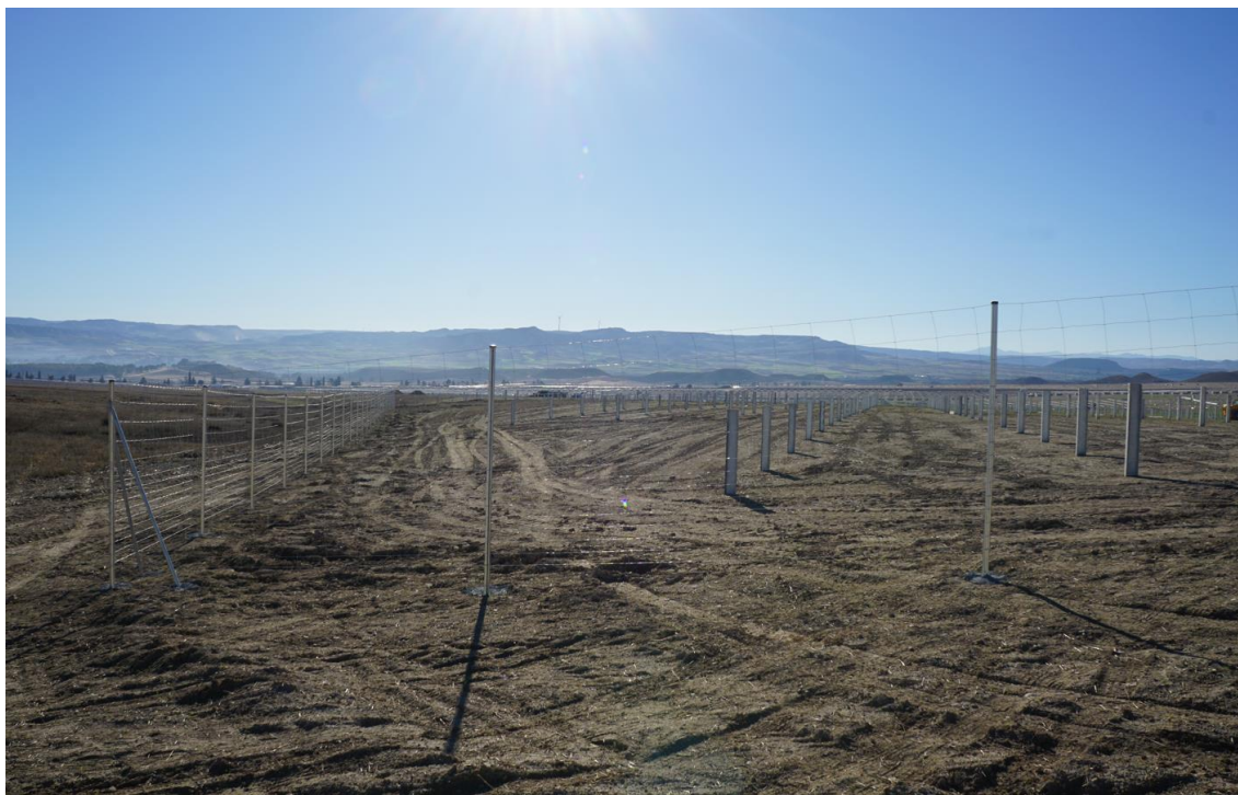
Figura 5 Vallado perimetral instalado en Vallobar
