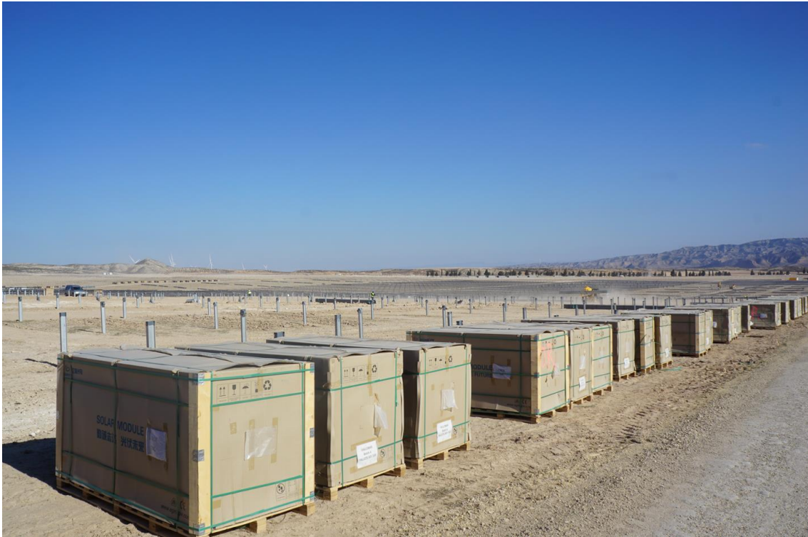
Figura 4 Acopio de placas fotovoltaicas previo a su instalación
