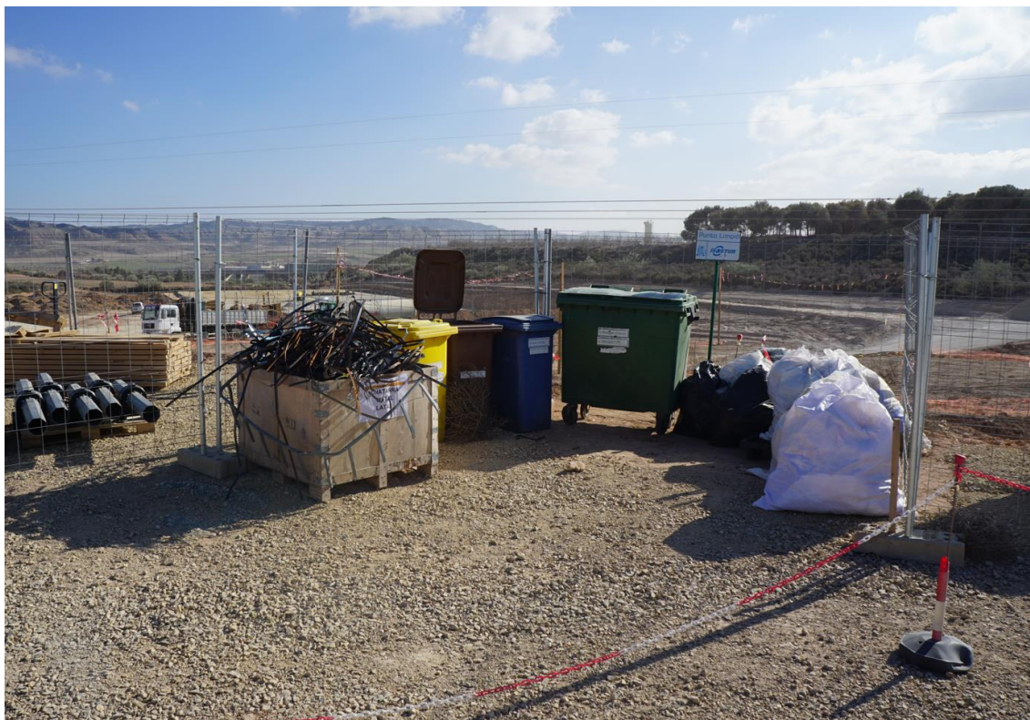
Figura 3 Punto limpio de residuos no peligrosos
