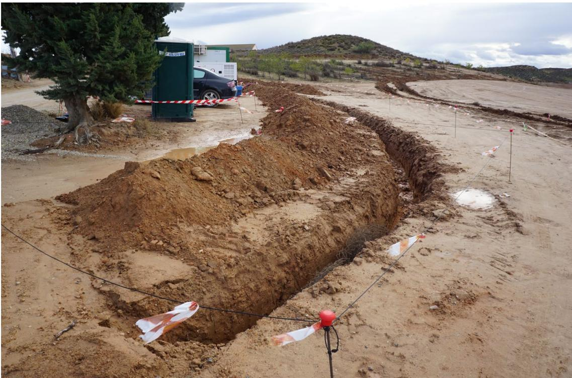
*Figura 8 Construcción de zanja para evacuación eléctrica*
