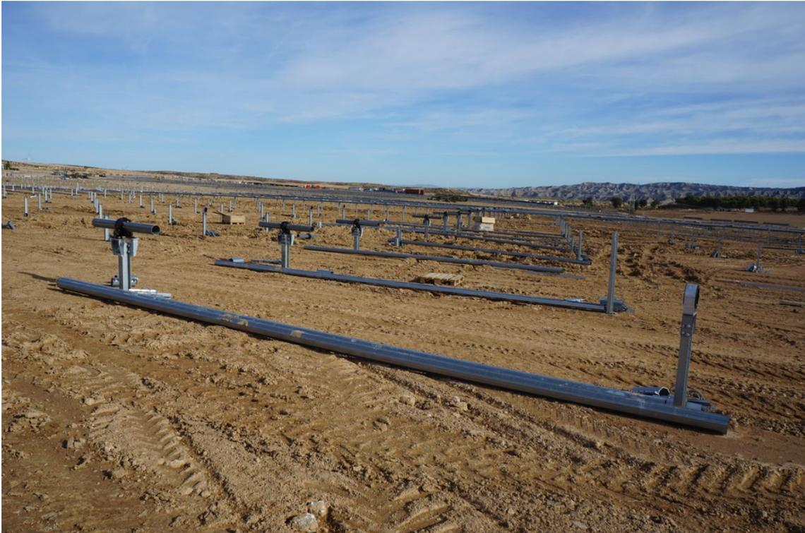
*Figura 3 Instalación de seguidores en Vallobar*
