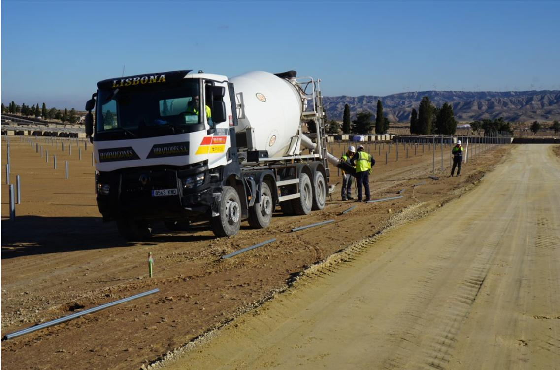
*Figura 9 Instalación de postes de vallado perimetral*
