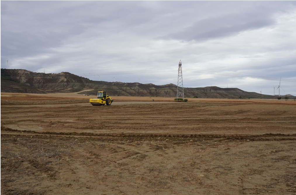
Figura 6 Acondicionamiento de superficies
