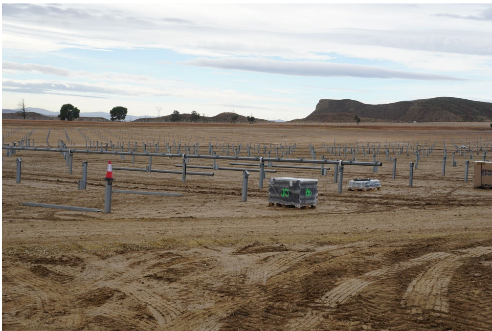
Figura 7 Montaje de seguidores en PFV Vallobar
