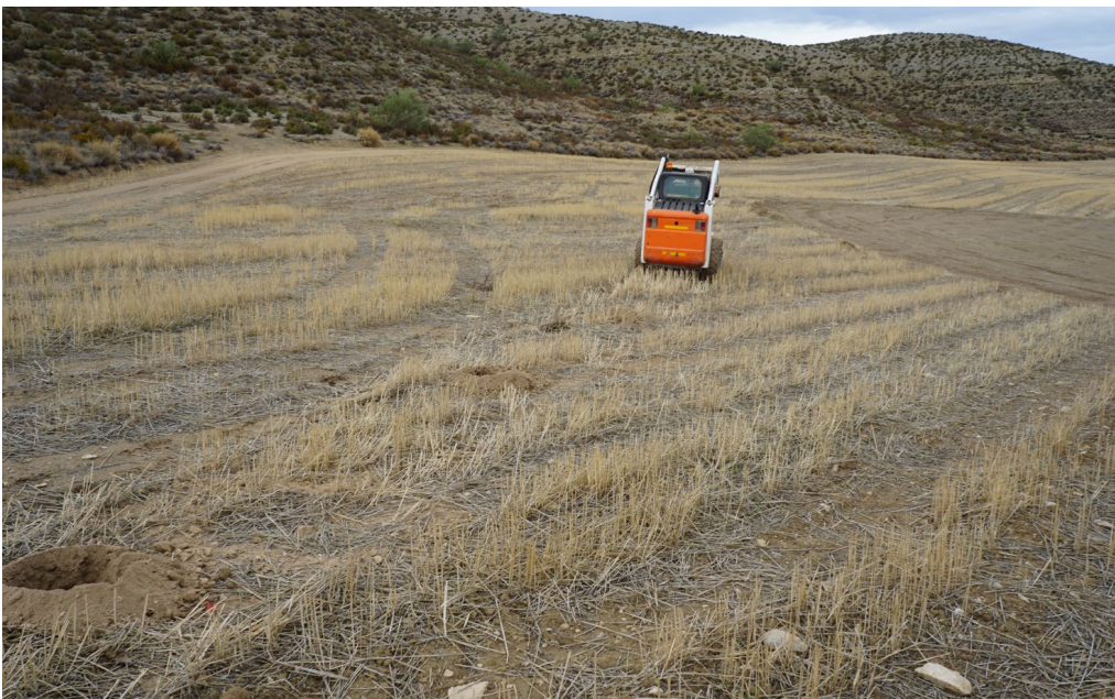
Figura 7 Ahoyado para postes de vallado perimetral
