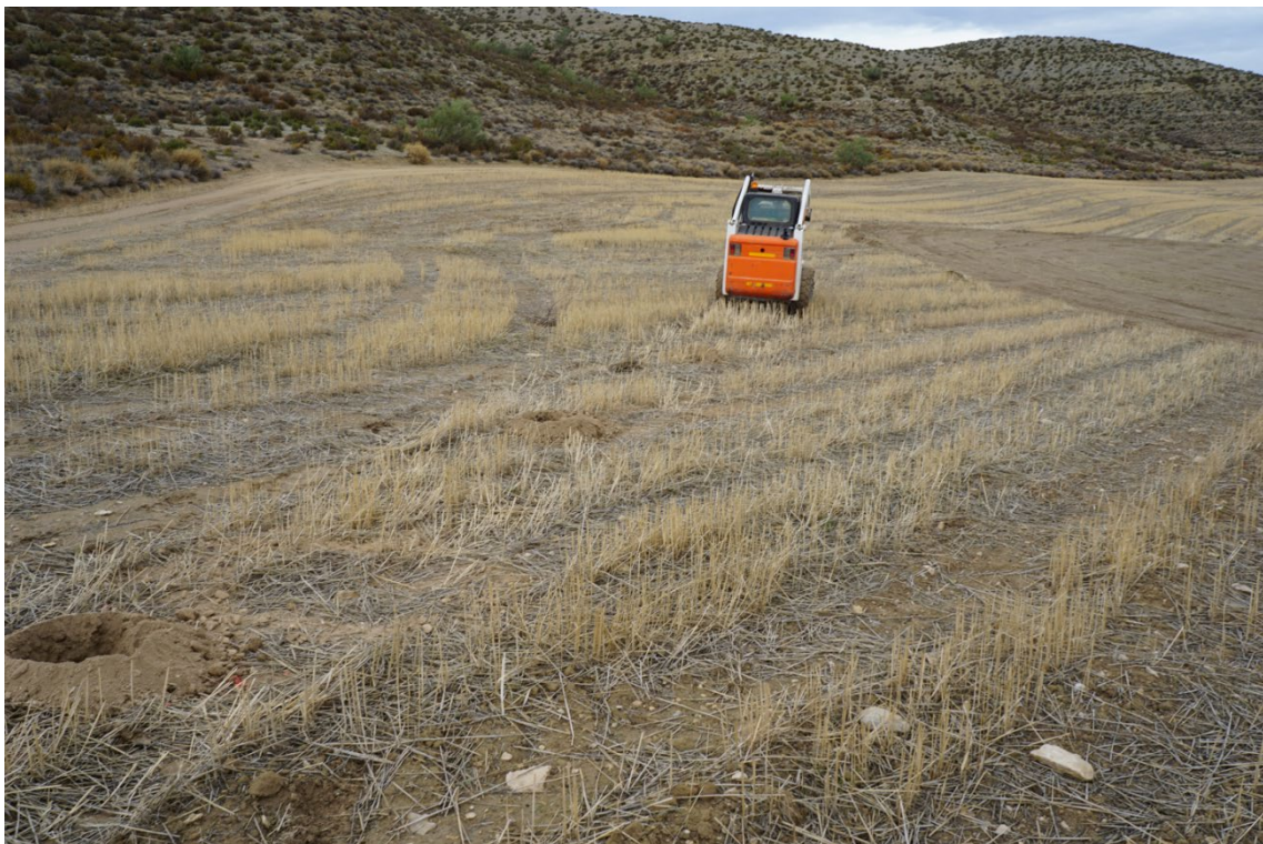
Figura 2a Trabajos de perforación para postes de vallado perimetral
