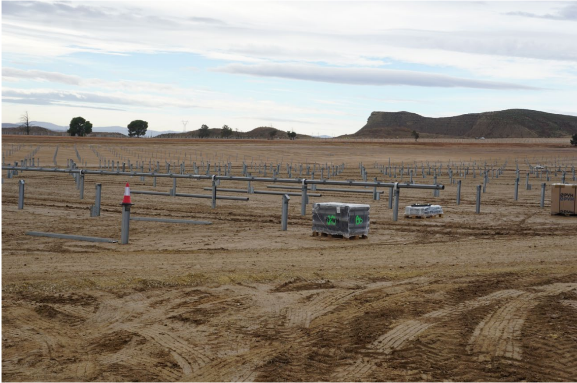
Figura 2b Montaje de seguidores
