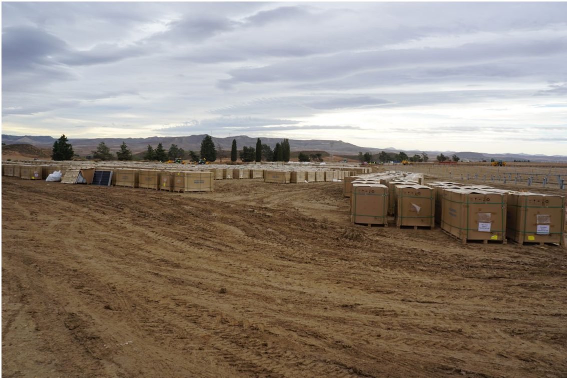
Figura 4 Zona de acopio
