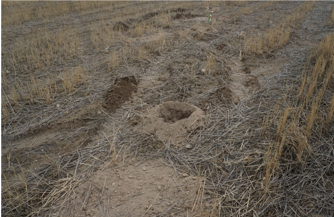
Figura 5 Ahoyado para instalación de vallado perimetral
