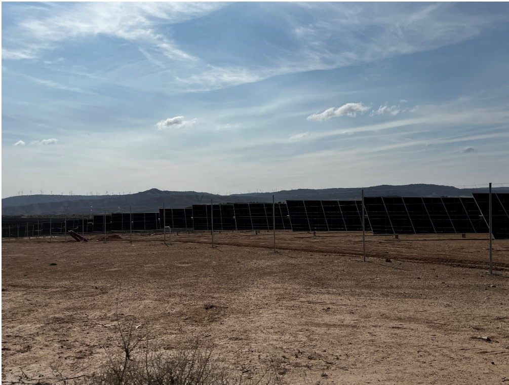
Figura 6 Vallado perimetral sin placas esteparias
