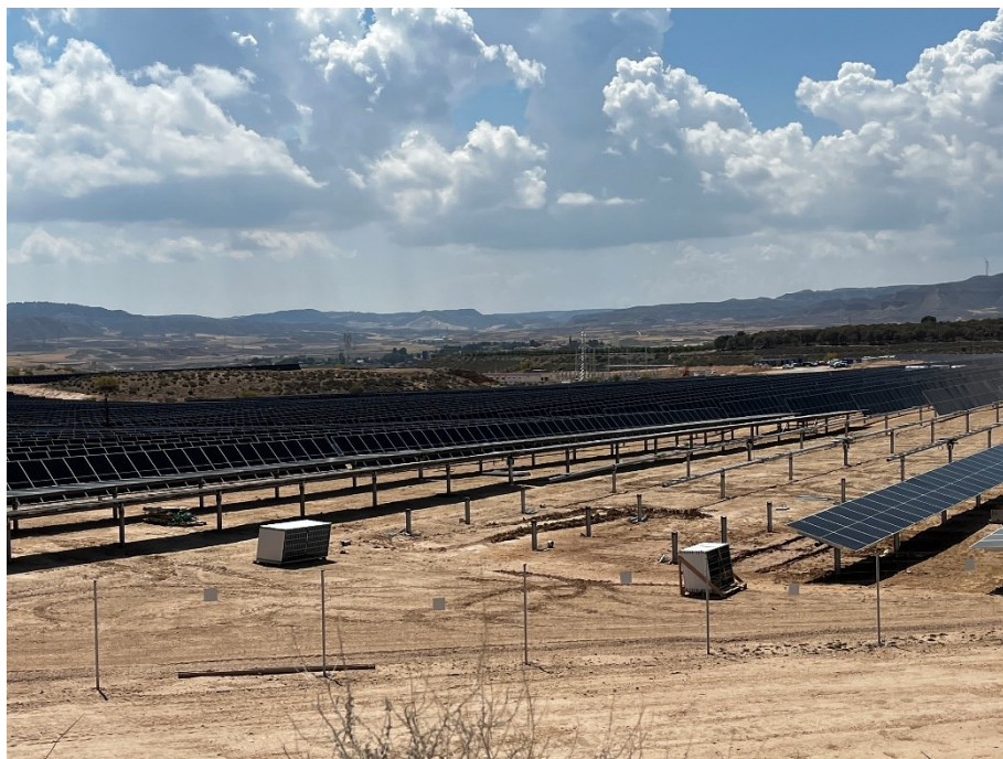
Figura 4 Montaje de los trackers y módulos
