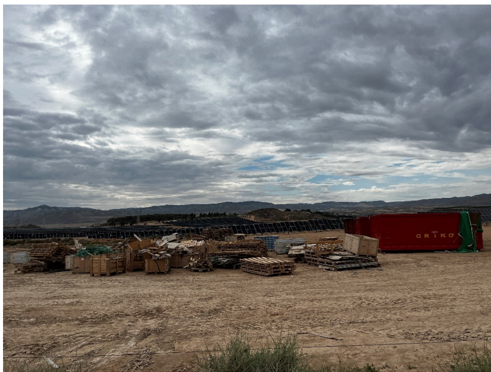
Figura 5 Punto limpio de residuos no peligrosos y acopio temporal de residuos
