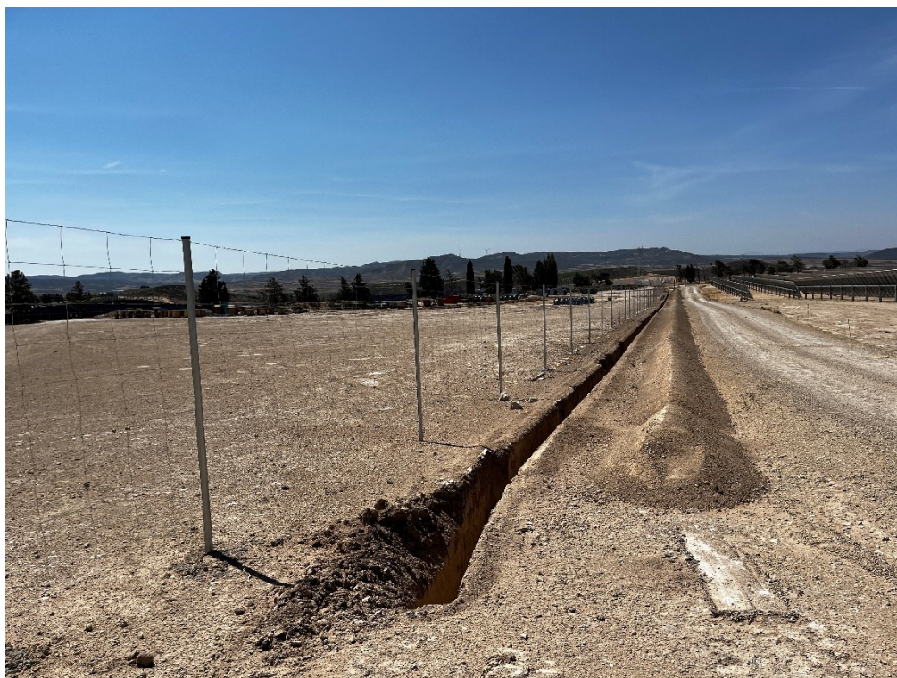
Figura 2 Apertura de zanjas para la red del CCTV
