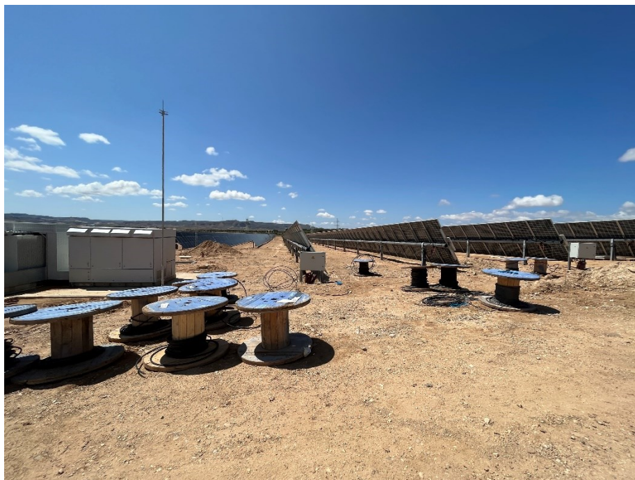
Figura 3 Cableado de la red de baja tensión
