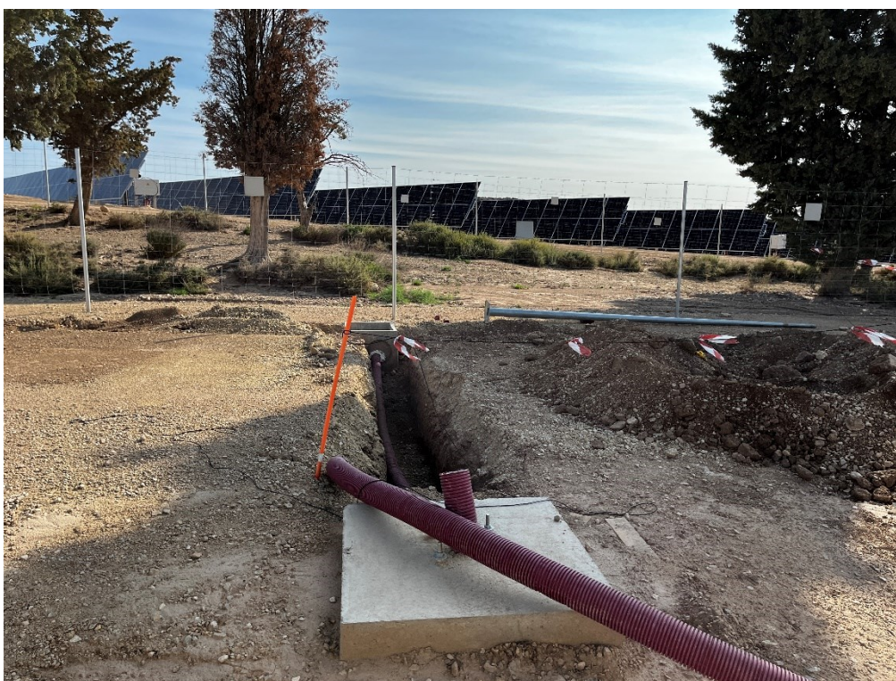
Figura 7 Zanjas para la red del CCTV
