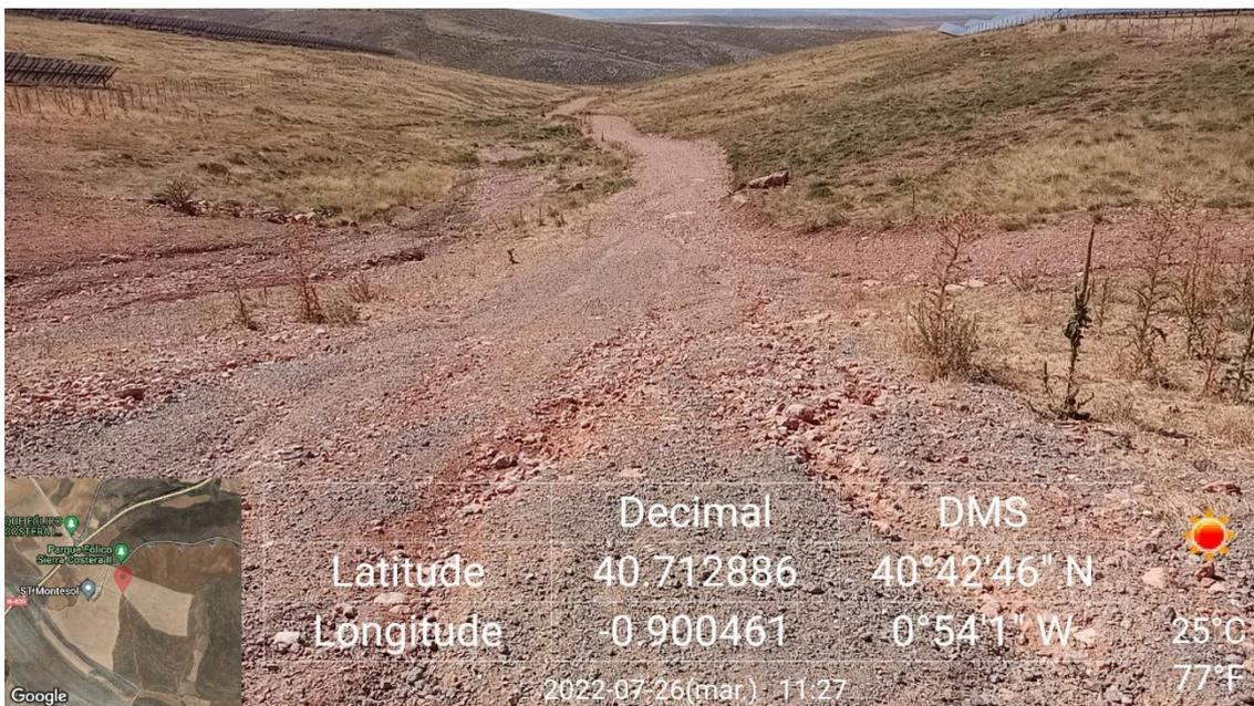
Ilustración 2. Erosión en un vial en campo 2.
