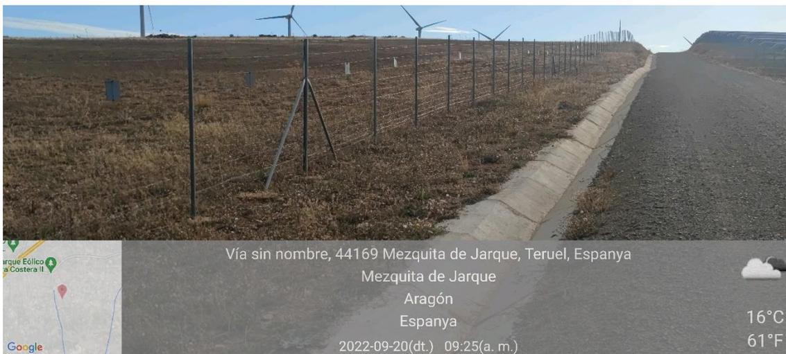
Ilustración 8. Canaletas cementadas sin acúmulo de materia y/o residuos.
