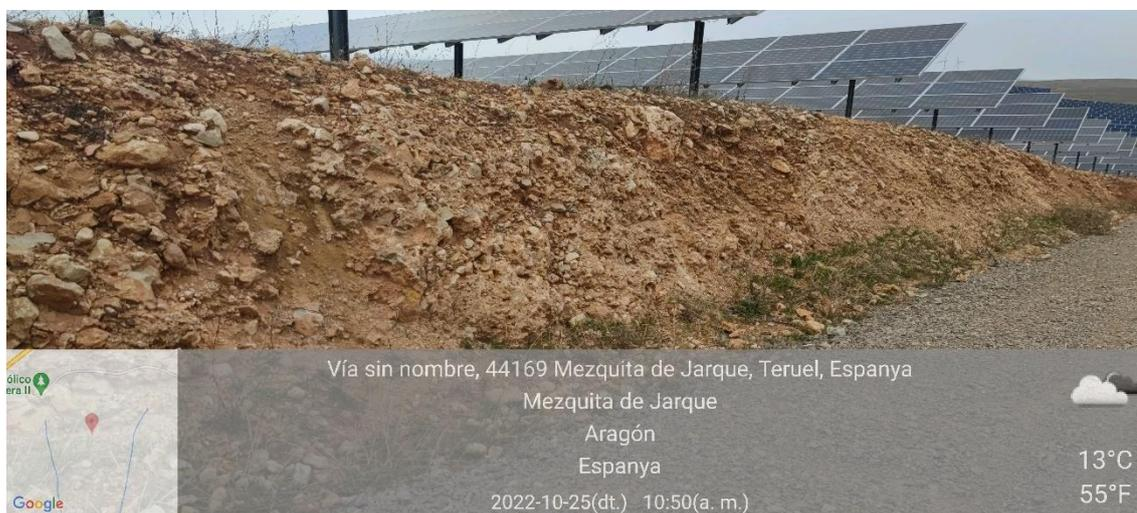
Ilustración 9. Erosión en taludes del campo 2.
