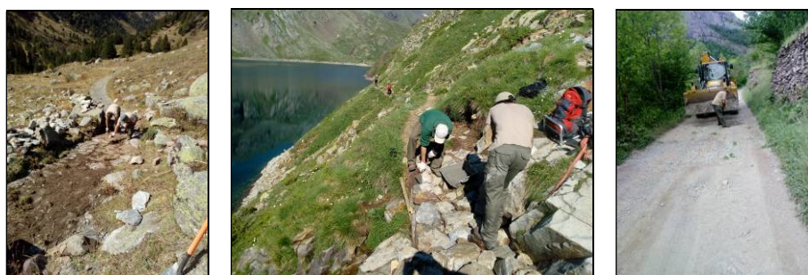
Enlosado de senderos en el sector de Benasque. Construcción de pavimento de piedra en senda Botornás. Bacheo de la pista del Viadós.
