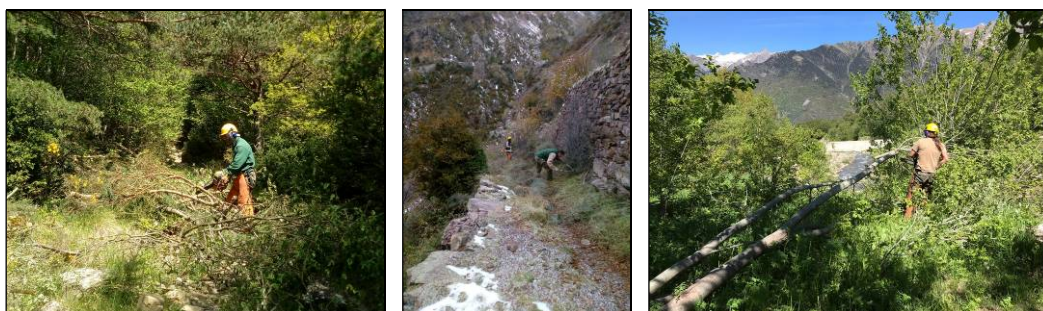
Desbroces en senderos: camino de Corberlo a Malmarrui (sector Monatnuy), sendero Fene Plan (sector Chistau) y camino Anciles a Cerler (sector Benasque)
