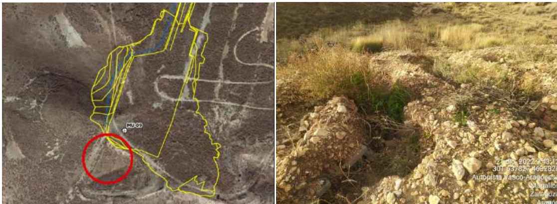
Figura 27: Fotografía y plano de localización de la erosión del talud al sur de la plataforma del aerogenerador MU-09. Pueden observarse varias cárcavas acusadas provocadas por el agua de precipitaciones torrenciales.
