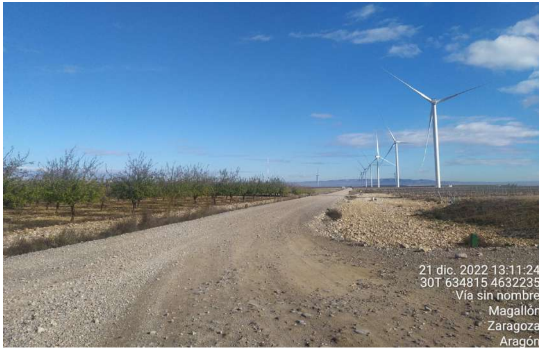
Figura 34: Vial de acceso a la altura de aerogeneradores MU-01, MU-02 y MU-03
