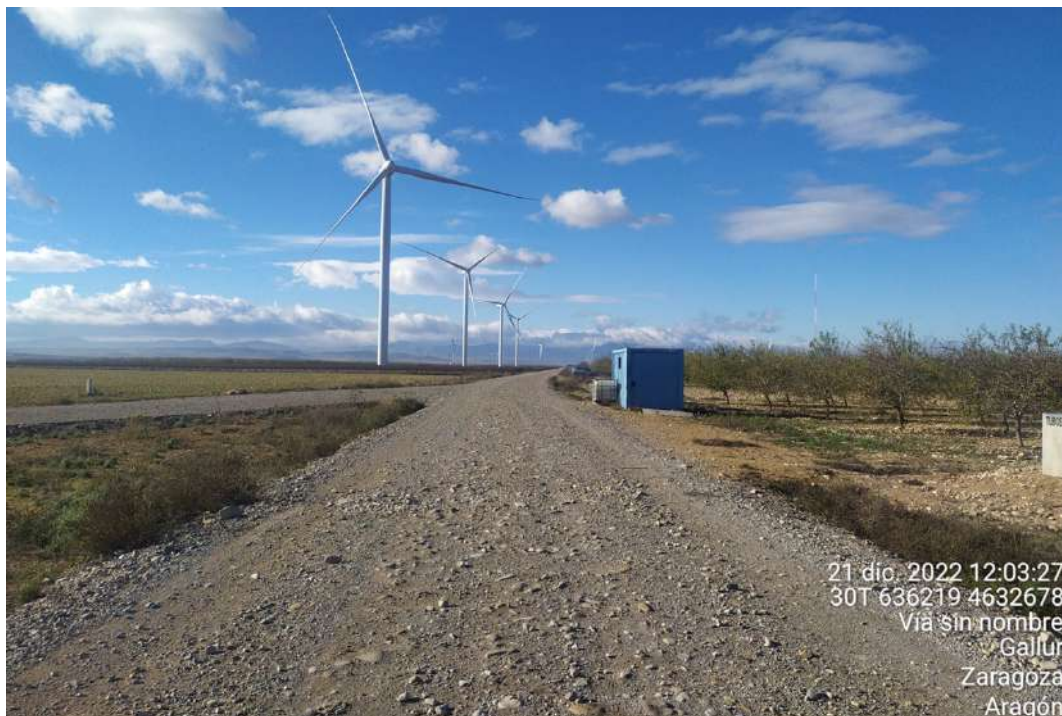
Figura 33: Vial de acceso a la altura de aerogeneradores MU-06 y MU-05.
