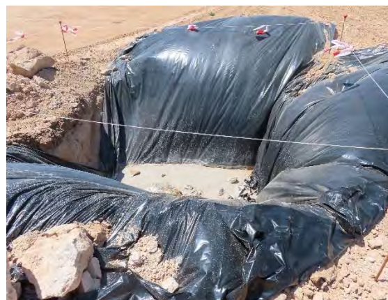
Pozo de lavado de hormigoneras
