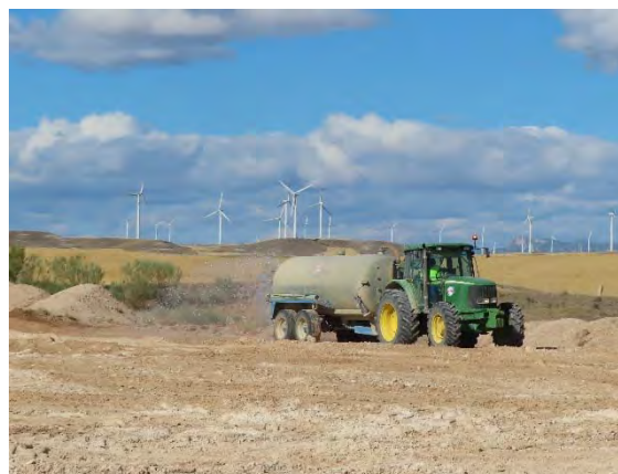
Riego de viales y plataformas para control del polvo.
