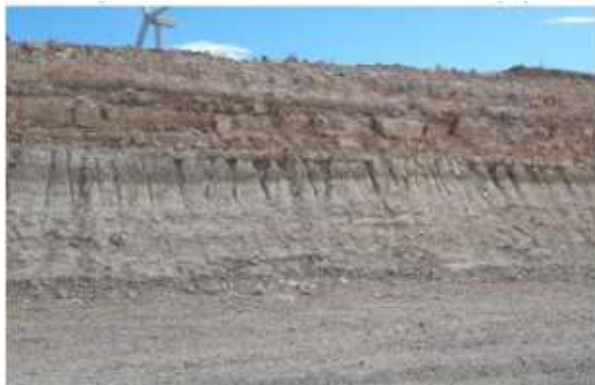
Fig. 3 Erosión hídrica en materiales margo-lutíticos del talud de desmonte de plataforma del aereo PO2.2.3. Fuente: Elaboración propia
