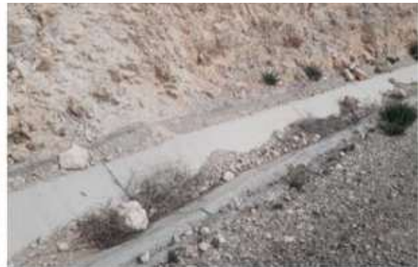
Fig. 2 Cuneta llena de sedimentos en vial de acceso al aero PO2.1.6. Fuente: Elaboración propia
