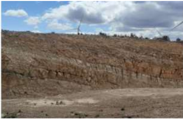
Fig. 1 Erosión hídrica en materiales margo-lutíticos del talud de desmonte de plataforma del aéro PO2.1.7. Fuente: Elaboración propia
