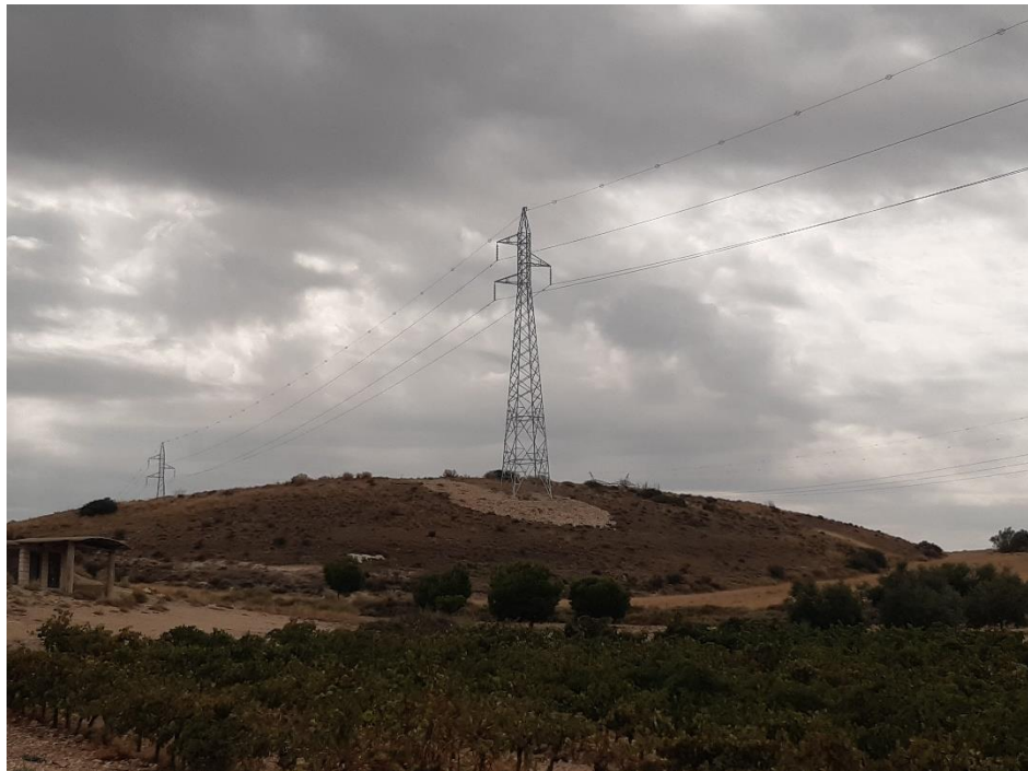
Estado de los apoyos 45 y 46
