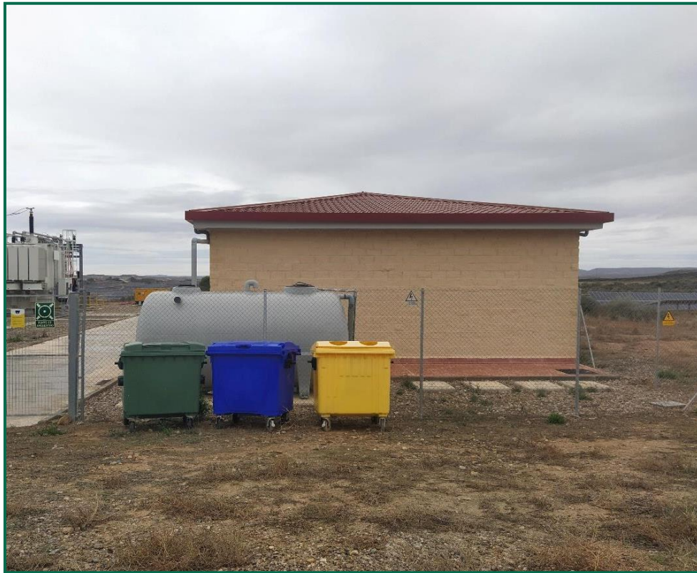
Fotografía 7. Contenedores de residuos no peligrosos en exterior de la subestación.
