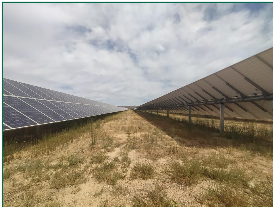
Fotografía 1. Vegetación entre placas actualmente.
