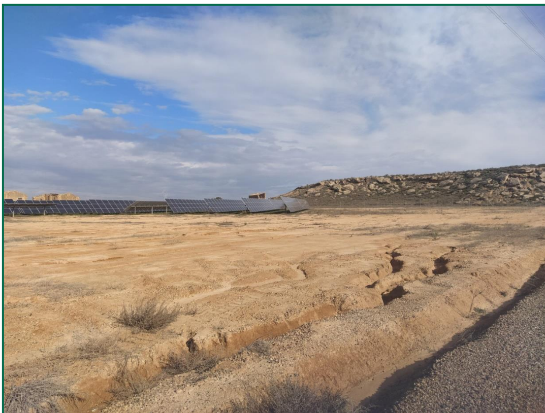
Fotografía 1. Zonas con erosión.
