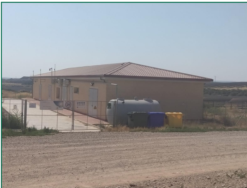
Fotografía 11. Contenedores de residuos no peligrosos en exterior de la subestación.
