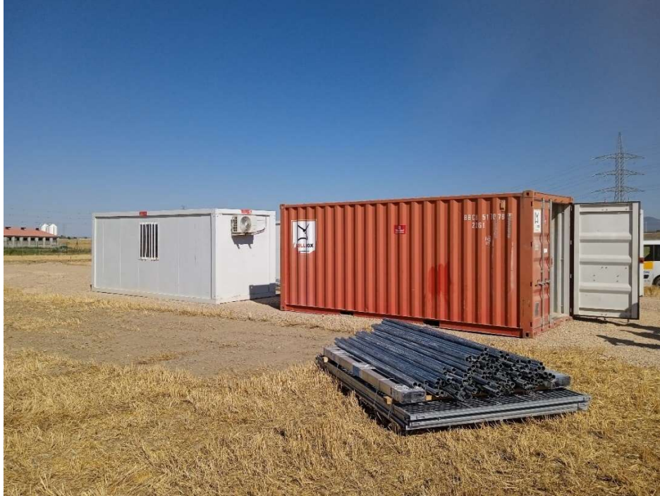
Imagen 9. Contenedor rojo habilitado como Punto limpio de residuos peligrosos.
