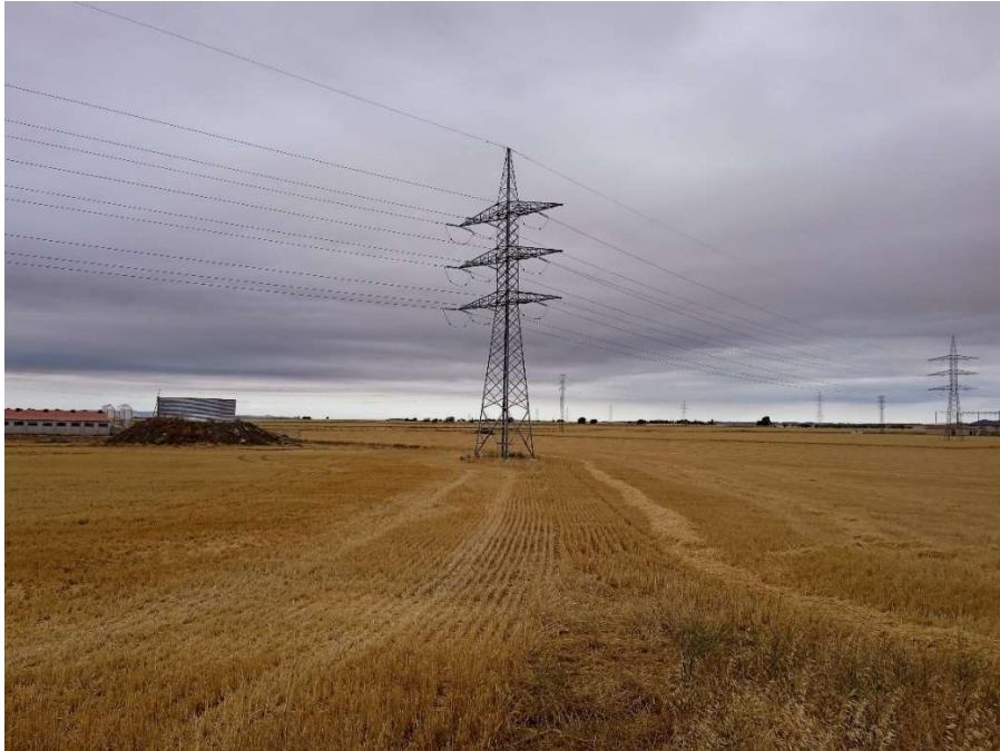
Imagen 3. Zona donde se ubicará el acceso Oeste y la SET, con la subestación eléctrica de Esquedas al fondo a la derecha.
