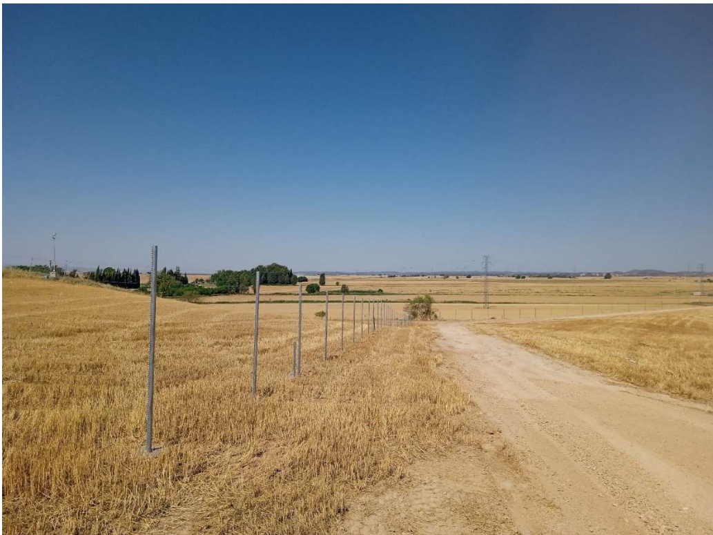
Imagen 6.- Vial perimetral terminado.
