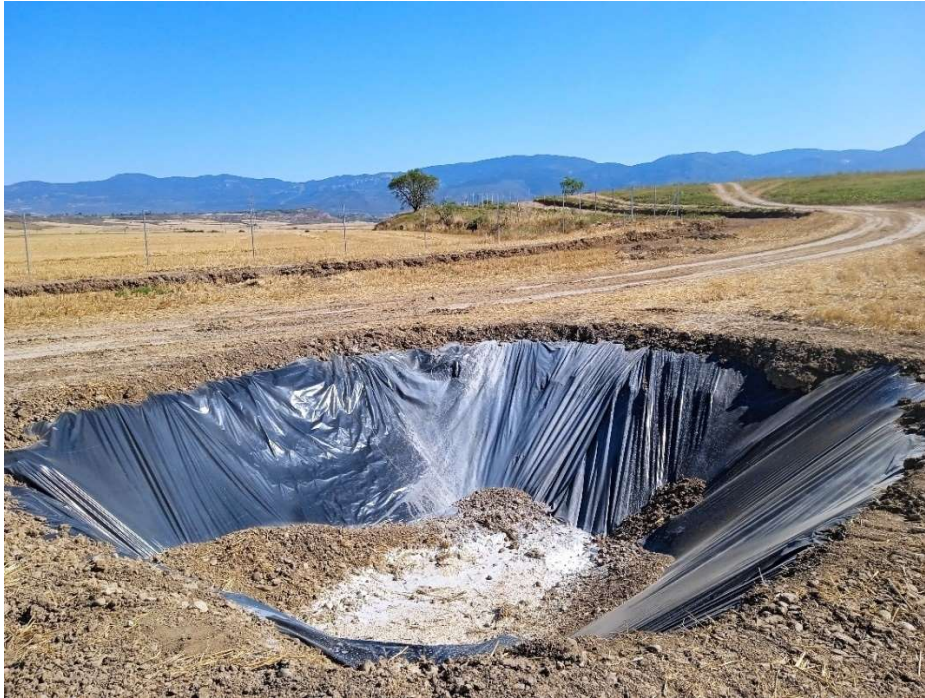
Imagen 11.- Balsa para limpieza de hormigoneras
