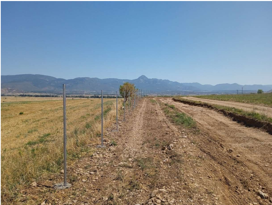
Imagen 13.- Espacio disponible para futura franja de vegetación entre vial en construcción y vallado, donde además ha de ir el cableado de seguridad.
