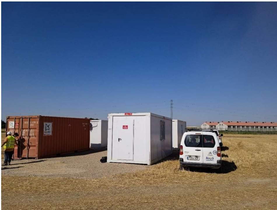
Imagen 8.- Zona de instalaciones auxiliares. Se aprecia el suelo sin tierra vegetal y con zahorra.
