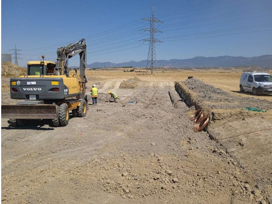
Imagen 7.- Trabajos en la Subestación de transformación
