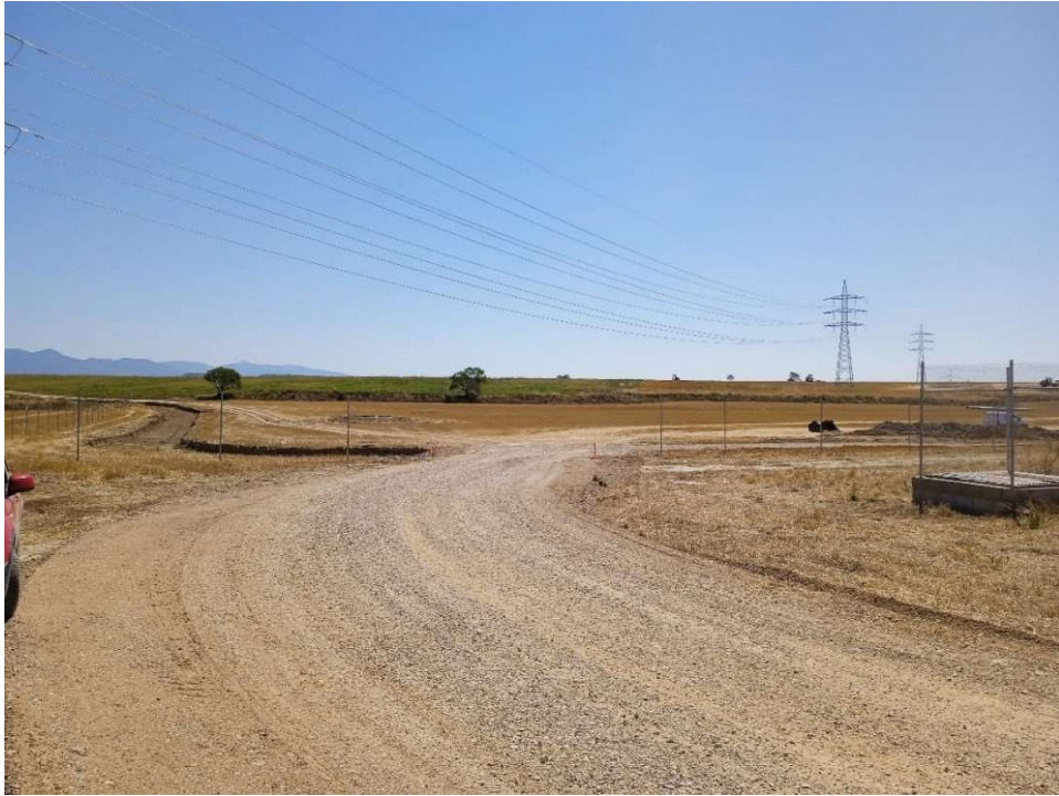
Imagen 1. Acceso Oeste principal con el vallado en construcción.
