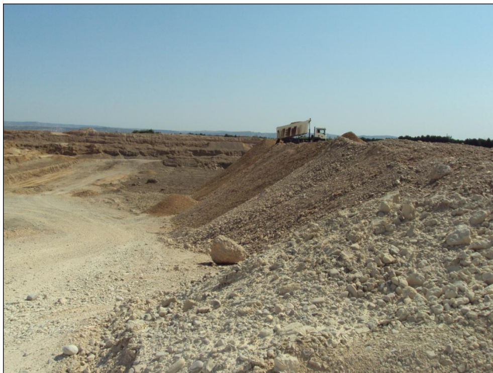
Fotografía.- Modelo del relleno tras la explotación hasta la cota diseñada.
