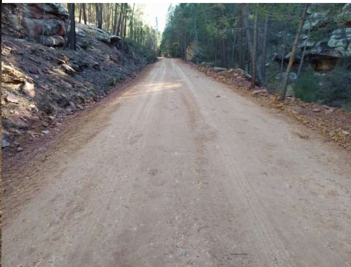
Estado del firme después de los trabajos.
