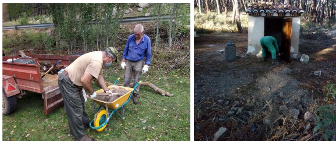
Acondicionamiento de bancos en área recreativa de Fuente Buena Arreglo de antiguo caseto de resineros en Bezas.
