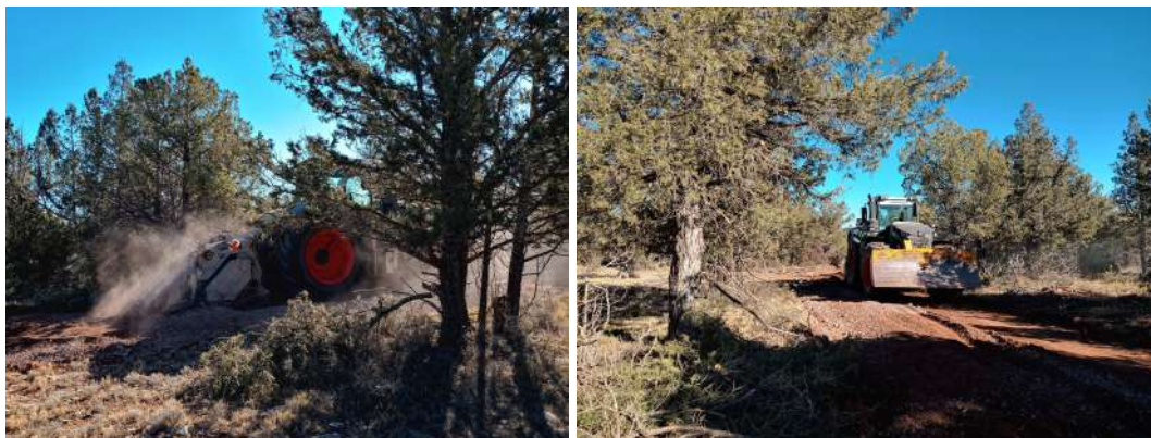
Maquinaria trabajando en la reparación de pistas.
