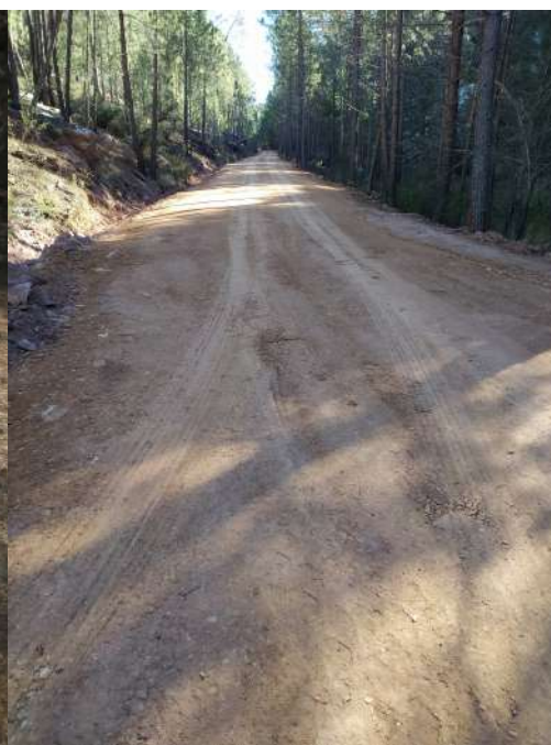
Estado del firme después de los trabajos.
