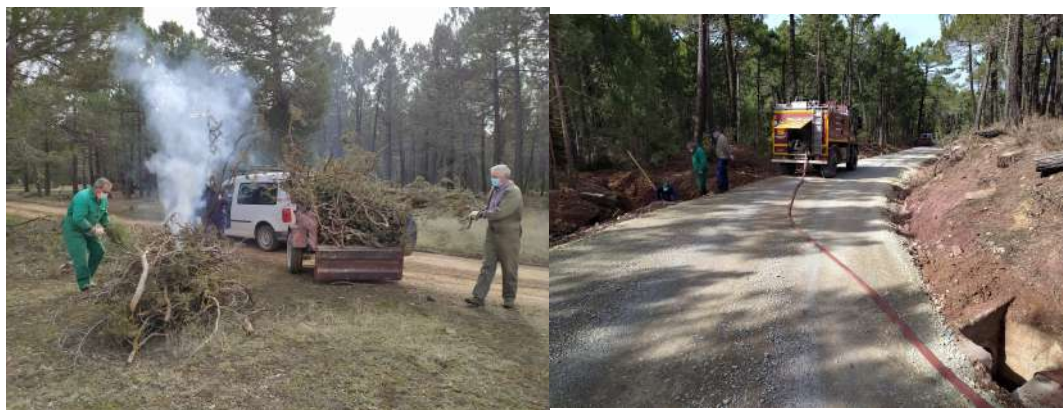
Quema de restos en el entorno de la Laguna de Bezas. Limpieza de pasos de agua con ayuda de la motobomba.
