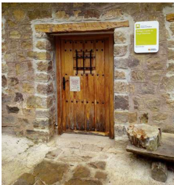
Señal colocada con el nombre del refugio en Ligros.
