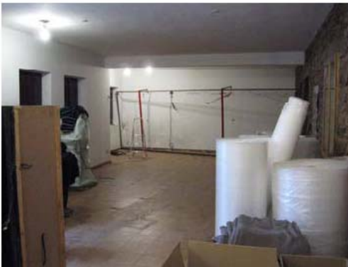
Trabajos de desmontaje de la antigua exposición del centro de interpretación de Agramonte.
