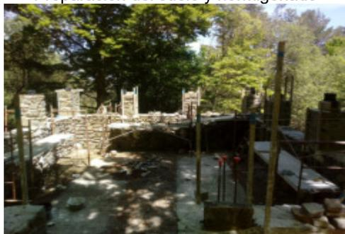
Colocación de pilares de piedra para mantener la pérgola y colocación de la misma
