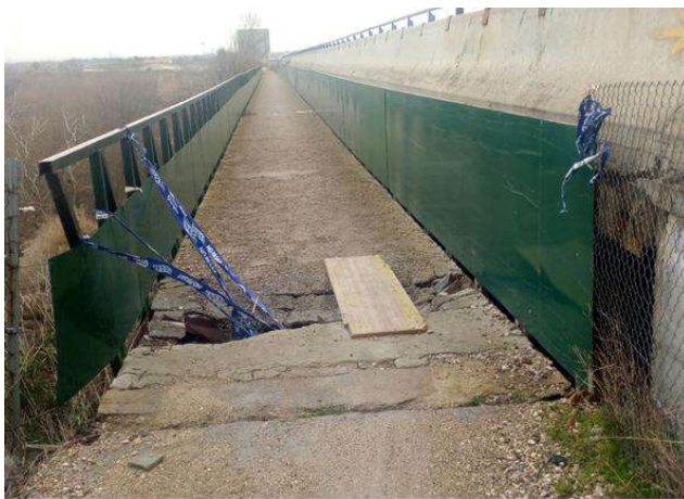
Mantenimiento de caminos acceso PSE y
