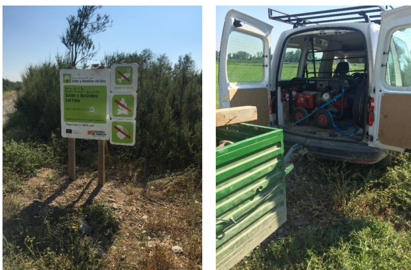
Fotos 20 y 21. Trabajos de mantenimiento en señalización.
