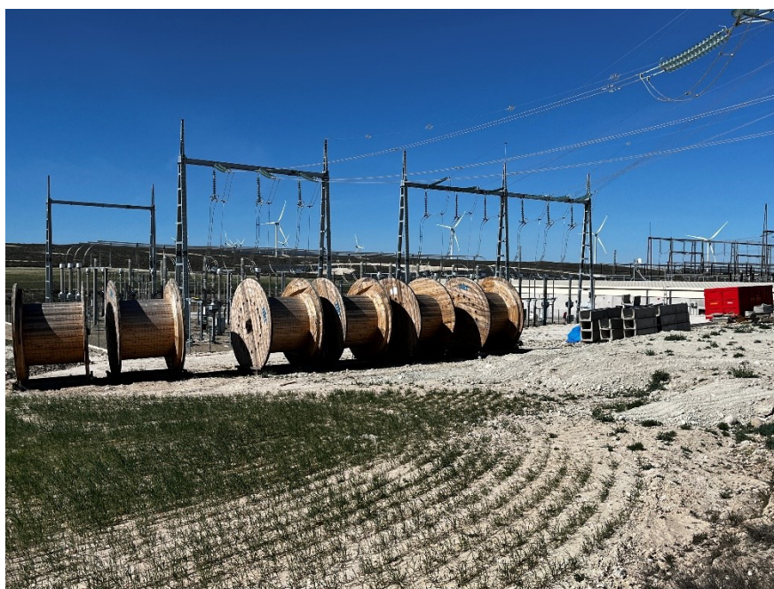
Figura 3 Acopio de material de construcción
