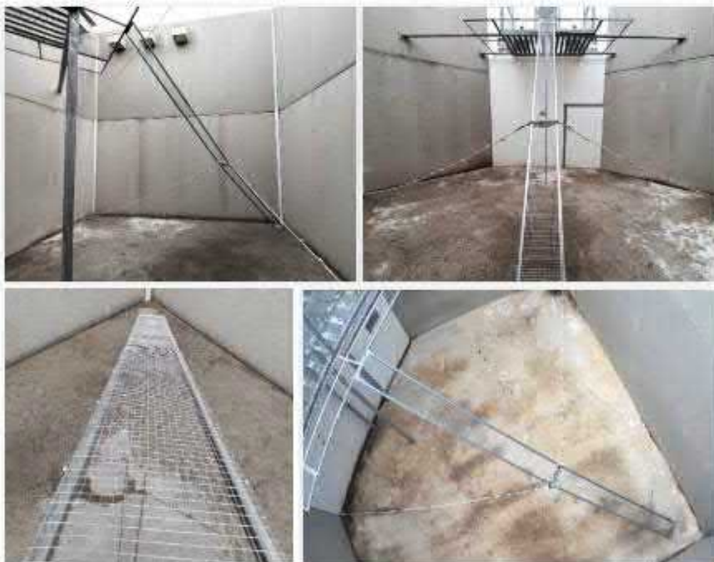
Rampa de acceso para pollos caídos y replanteamiento de las cuerdas con menos inclinación
