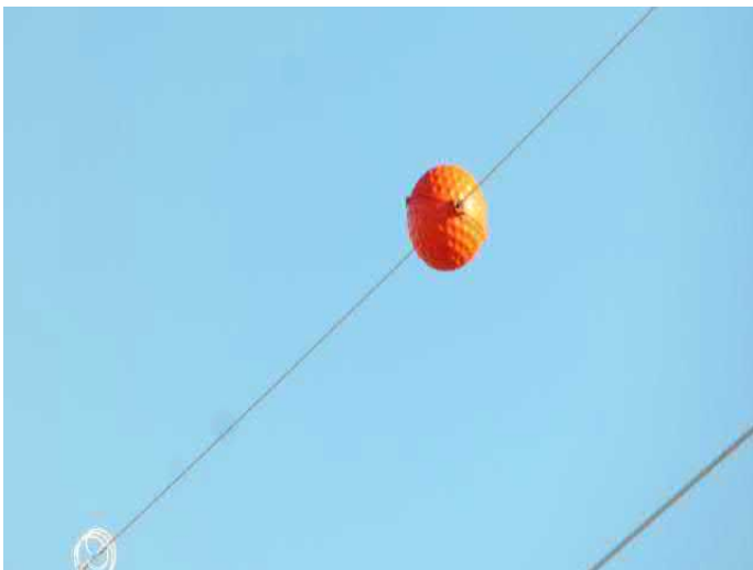
Imágenes 1 y 2: Estado de conservación de baliza esférica (Izquierda), y aisladores (derecha)
