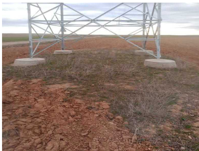
Imagen 5: Base del apoyo de la LAAT, colonizada de manera espontánea por vegetación natural.
