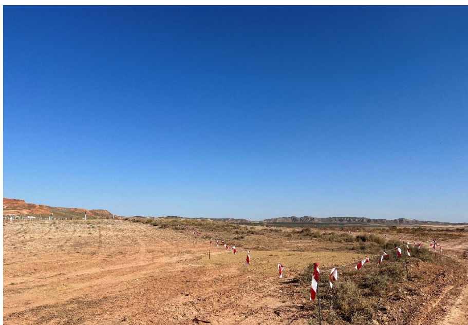
Figura 7 Balizado de zona de vegetación natural
