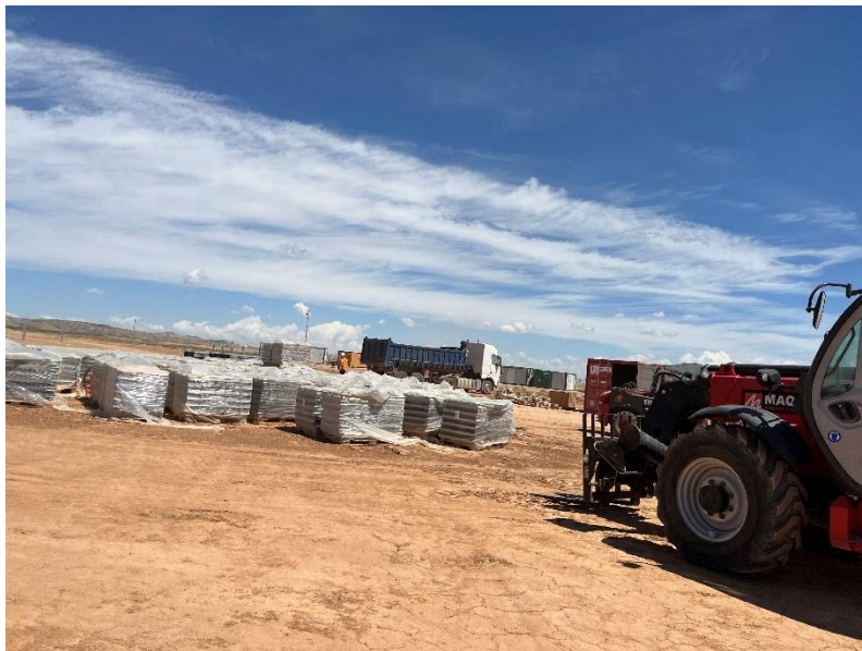
Figura 4 Zona de acopio
