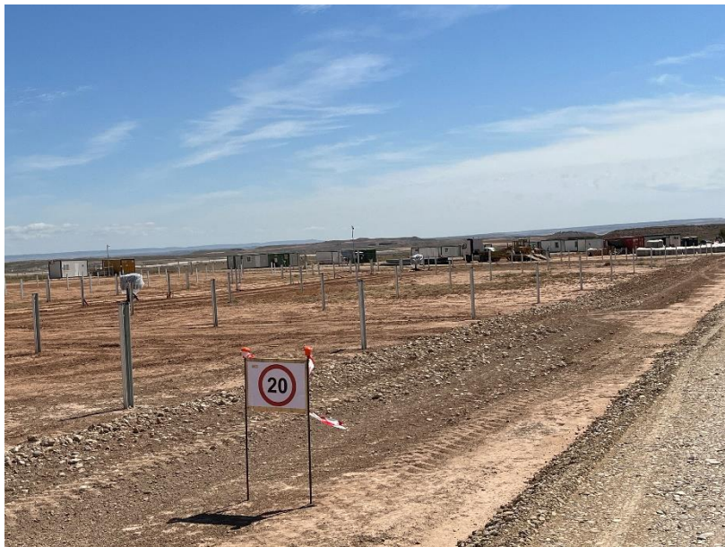
Figura 5 Señalización en obra
