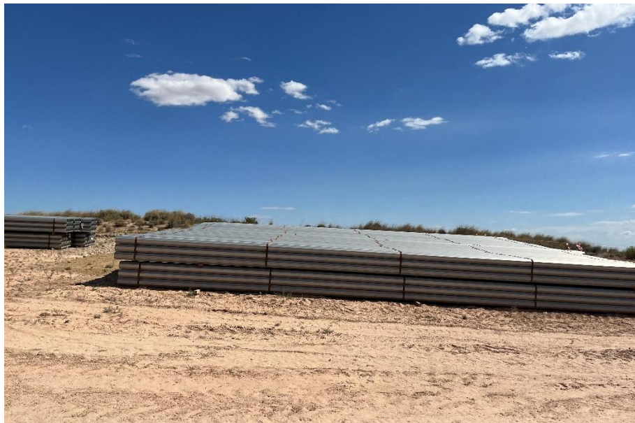
Figura 6 Zona de acopio
