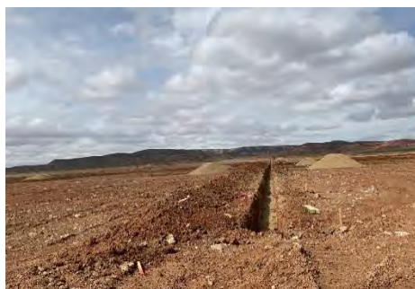
Figura 3 Apertura de zanjas
