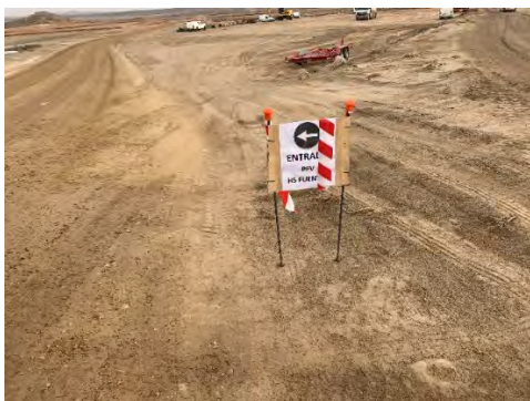
Figura 20 Señalización en obra
