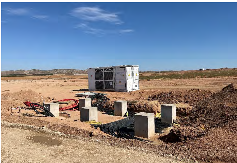
Figura 44 Cimentación de la base de los CT
