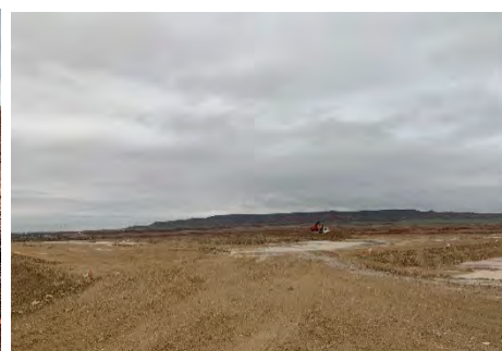
Figura 5 Apertura de viales
