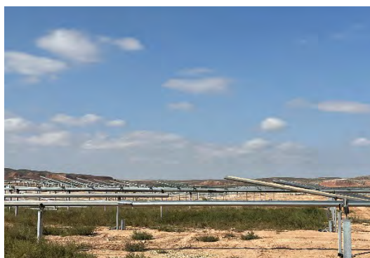
Figura 7 Montaje de los trackers
