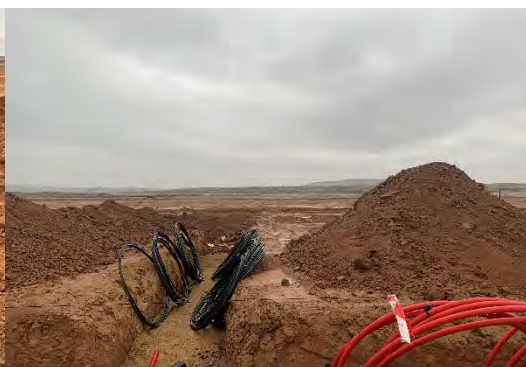
Figura 10 Tendido de cable de media tensión
