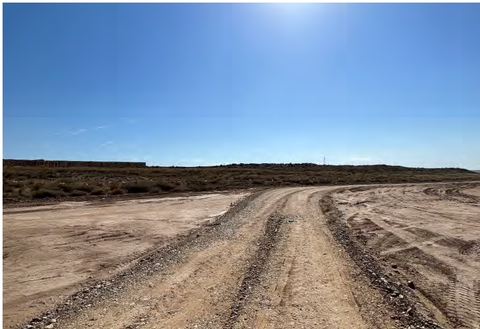
Figura 43 Apertura del vial interno
