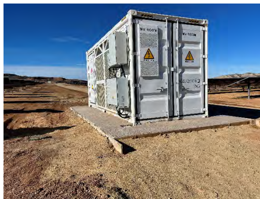
Figura 27 Labores de cimentación
