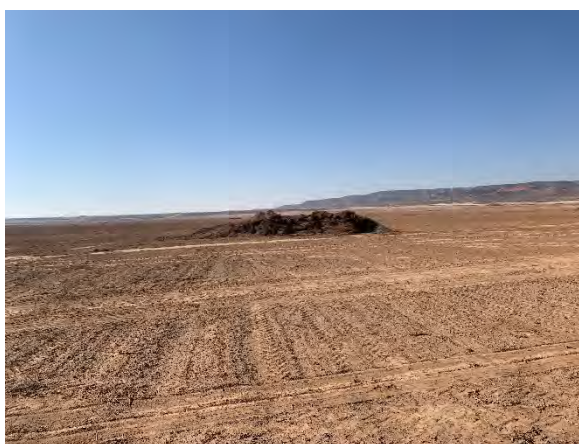
Figura 19 Acopio de tierra vegetal
