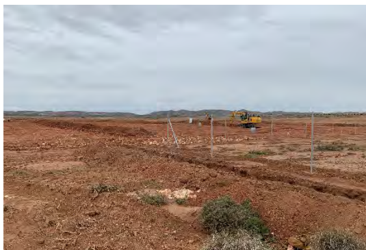
Figura 39 Instalación del vallado perimetral
