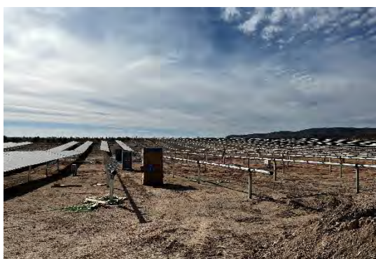
Figura 8 Montaje de los módulos fotovoltaicos
