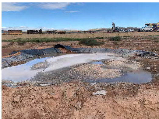
Figura 28 Lavadero de cubas de hormigón
