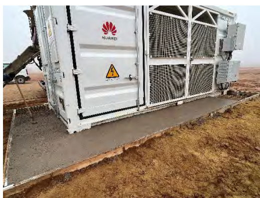
Figura 26 Labores de cimentación
