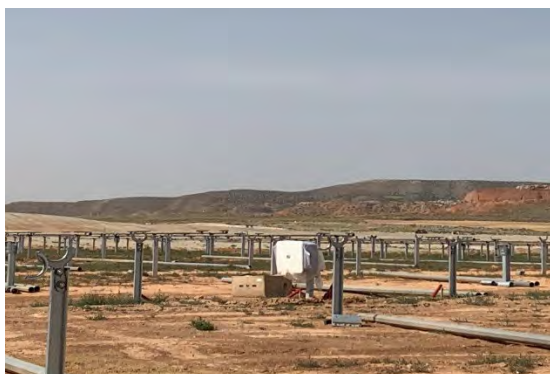
Figura 11 Montaje de los inversores
