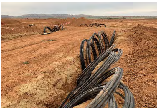
Figura 9 Tendido de cable de baja tensión
