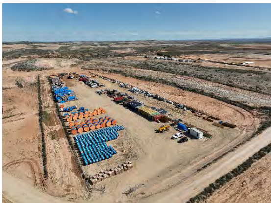
Figura 22 Zona de acopio del material de construcción
