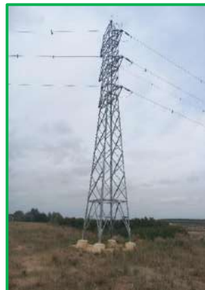
Figura 4: Vista del Apoyo 1 de LAAT (31/10/2022)
