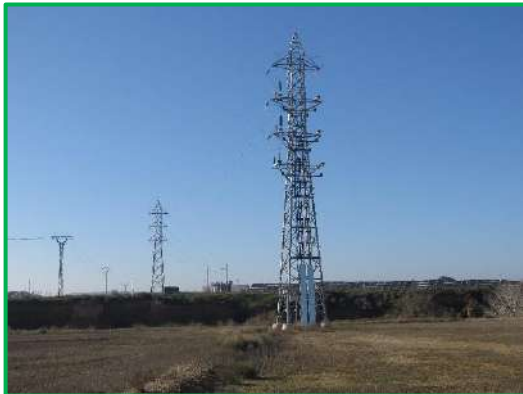
Figura 6: Vista del apoyo 3 de la LAAT.
