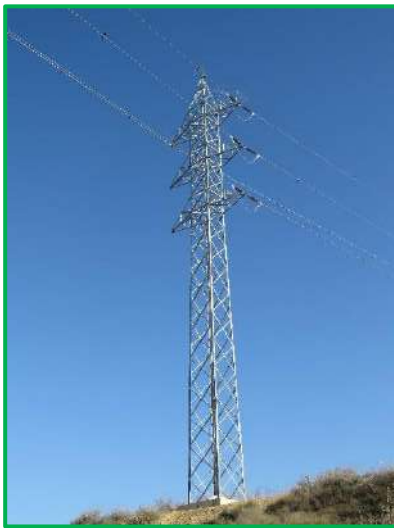
Figura 8: Vista del apoyo 5 de la LAAT.
