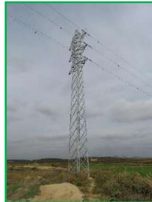
Figura 7: Vista del apoyo 4 de la LAAT.
