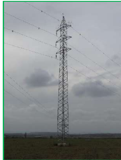
Figura 9: Vista del apoyo 6 de la LAAT.
