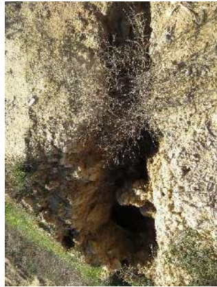
Figura 21: Detalle del desprendimiento en la zona de trackers Figura 22: Cantos rodados para estabilizar el anterior
