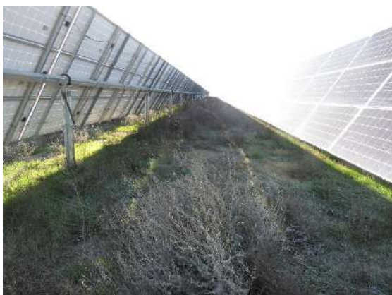
Figura 26: Vegetación existente em visita 30/01/23
