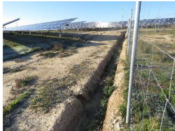
Figura 24: Cuneta recogida de aguas pluviales
