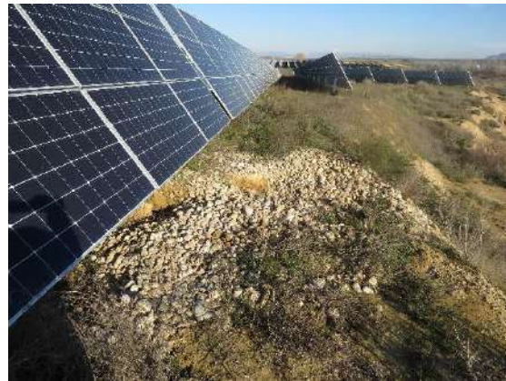
Figura 21: Detalle del desprendimiento en la zona de trackers Figura 22: Cantos rodados para estabilizar el anterior
