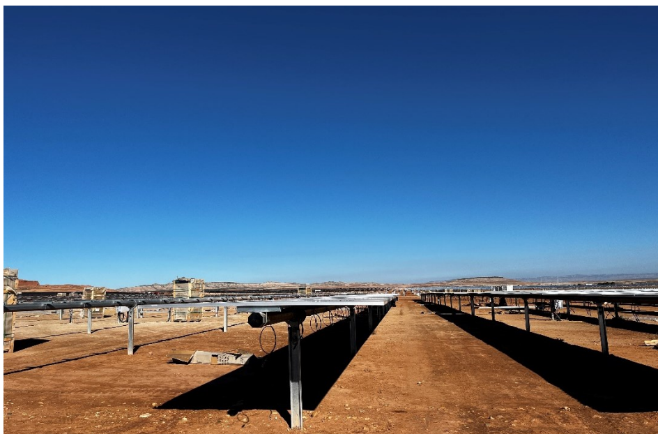
Figura 6 Montaje de los módulos
