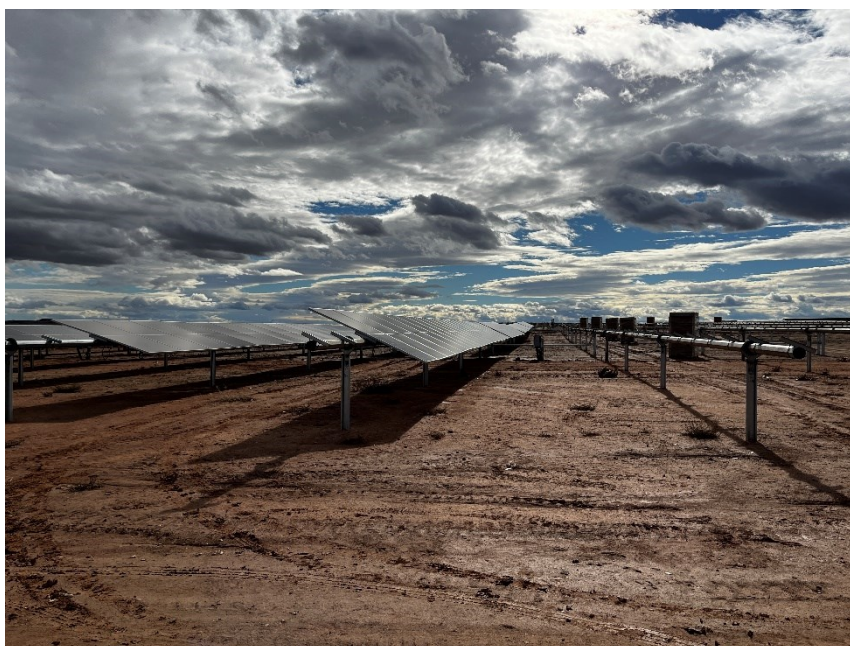
Figura 2 Montaje de los módulos
