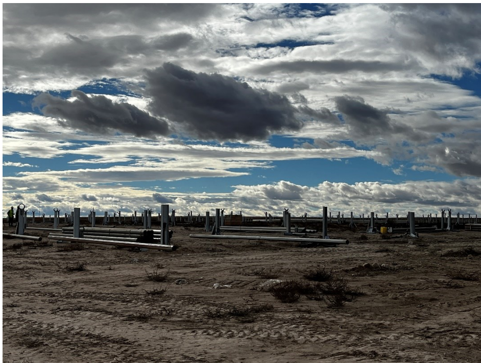
Figura 9 Montaje de los torques
