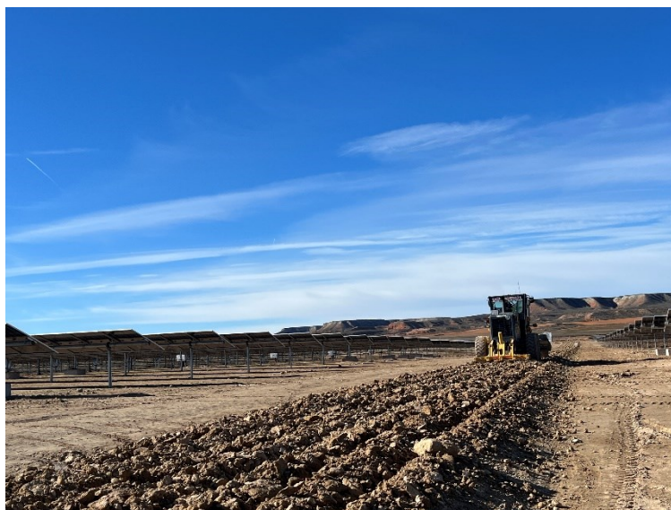
Figura 2 Rehabilitación del vial interno
