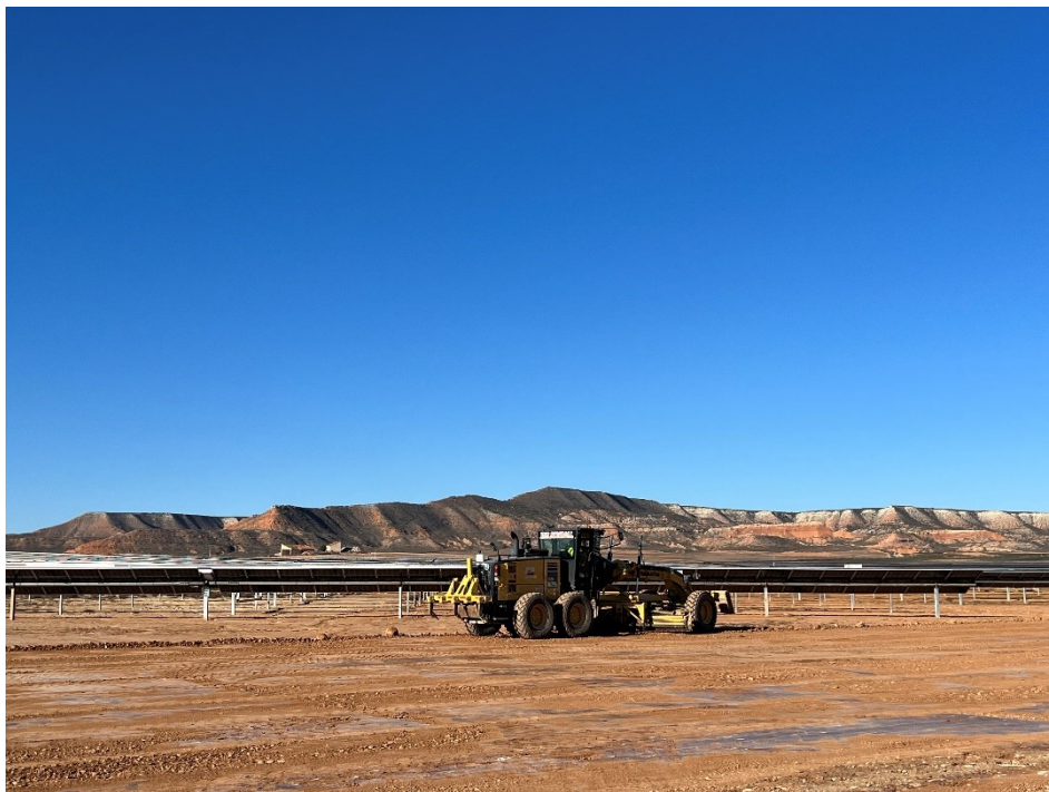
Figura 9 Nivelaciones del terreno
