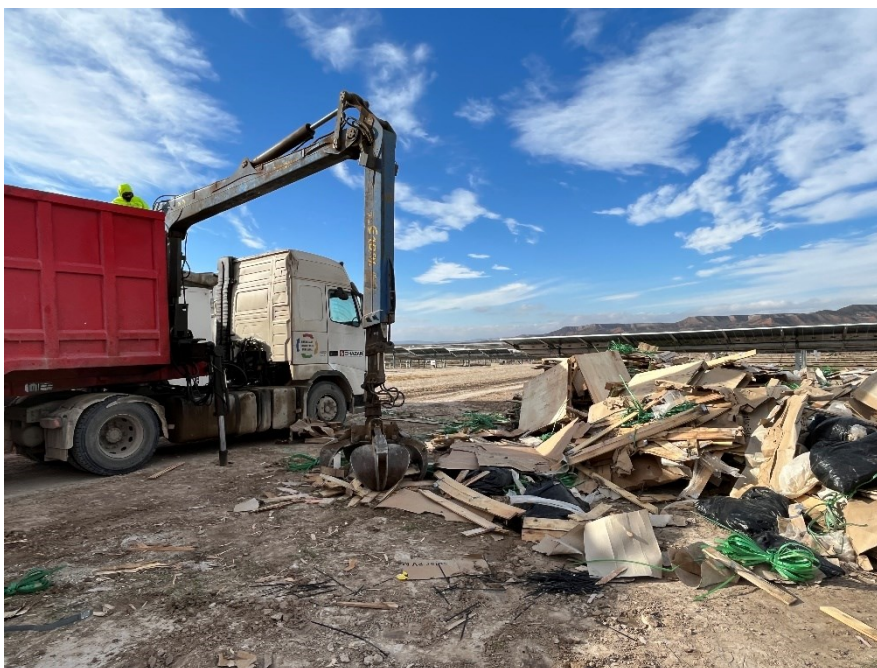
Figura 3 Retirada de acopio temporal de RNP
