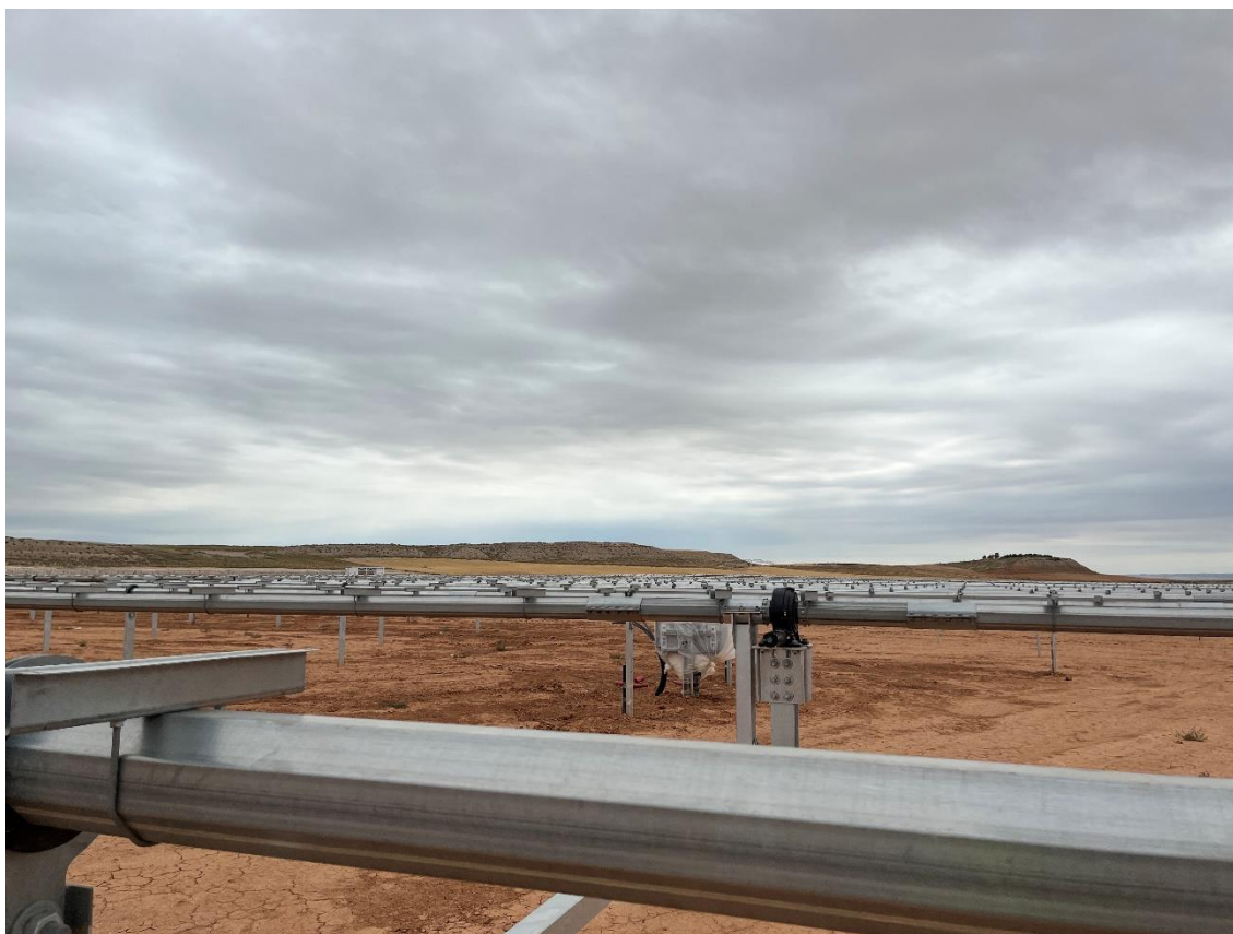
Figura 2 Montaje de los trackers
