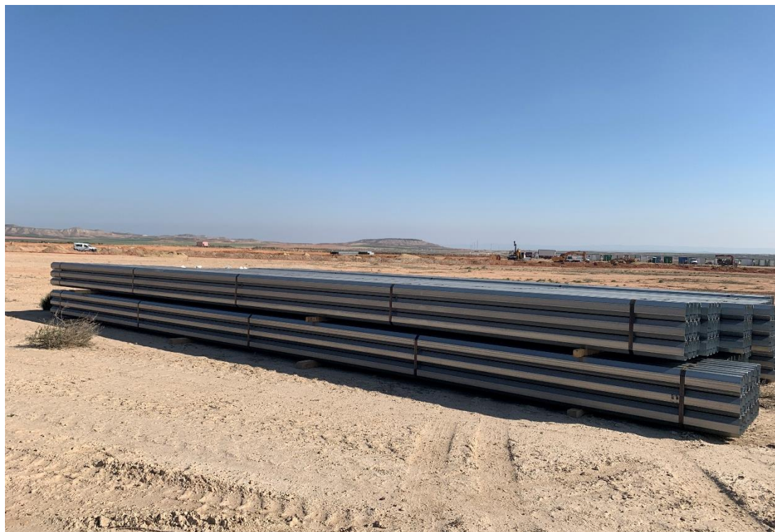
Figura 5 Zona de acopio
