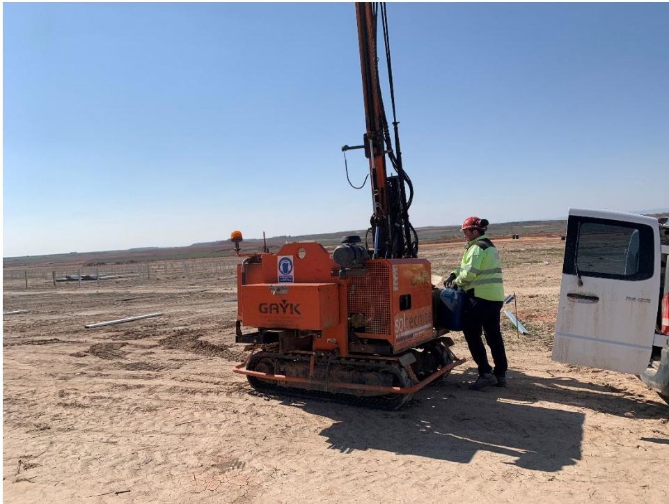
Figura 8 Hincado de la estructura
