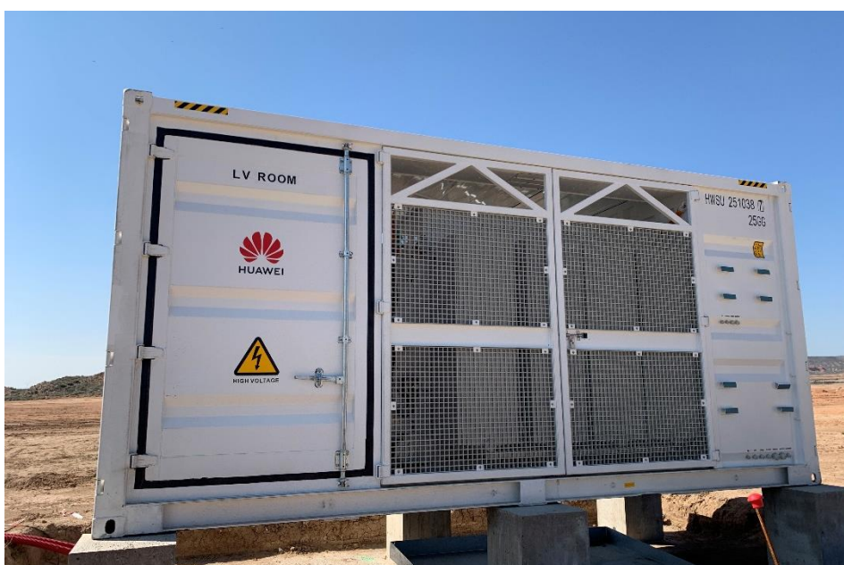
Figura 7 Colocación del centro de transformación
