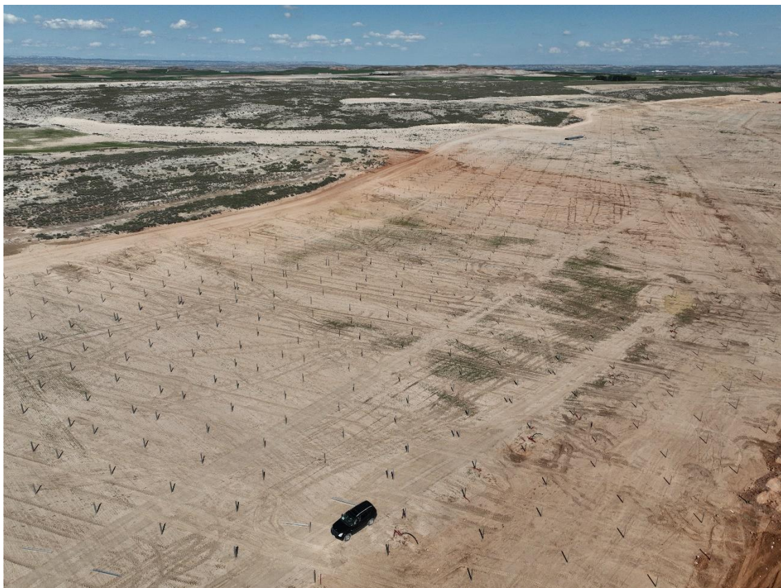
Figura 3 Hincado de la estructura
