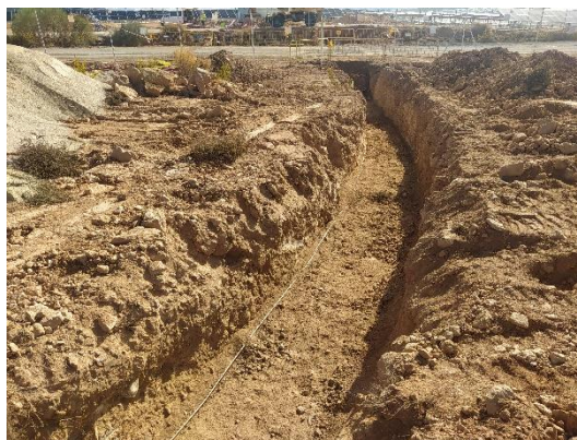
Fot 1 y 2. Ejecución de la zanja de evacuación de MT y BT en Pitarco B1 y B2.
