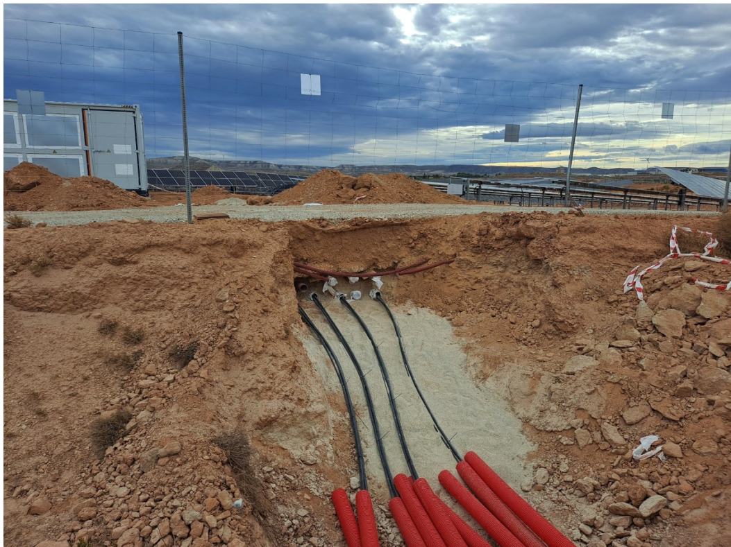
Foto 11. Cruce carretera para conectar de forma soterrada Pitarco B
