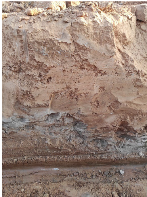
Fot 3. Perfil de la zanja de evacuación.
