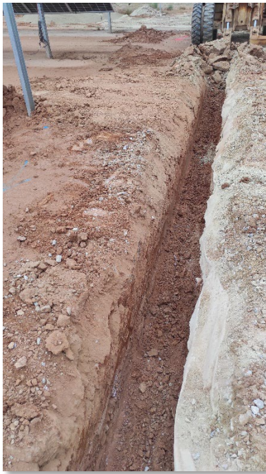
Fot 1 y 2. Ejecución de la zanja de evacuación de MT y BT en Pitarco B1 y B2.
