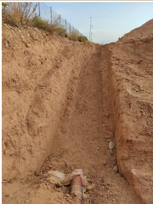
Fot 1 a 4. Zanja de conexión entre la SET PSFV Pitarco y la SET "Polígono Pitarco" .
