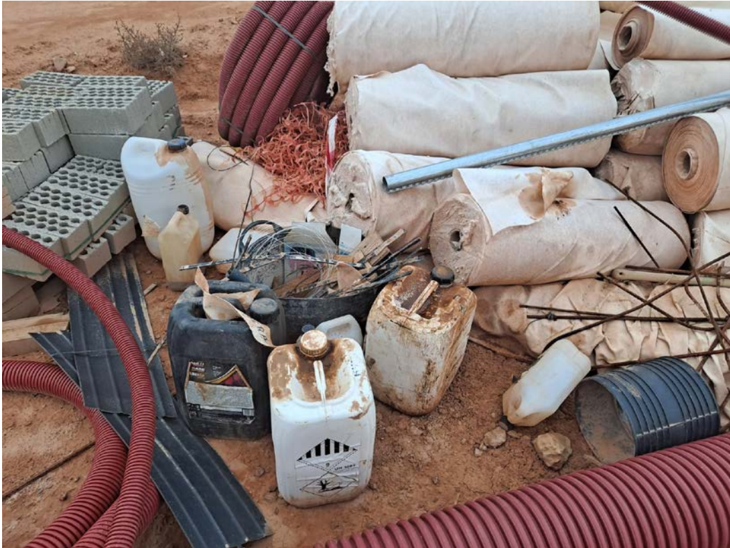
Foto 5. No Conformidad a la empresa subcontratista por almacenar residuos de envases peligroso en obra de forma incorrecta
