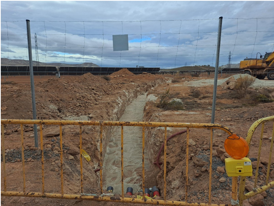
Foto 10. Cama de arenado en fondo de zanjas
