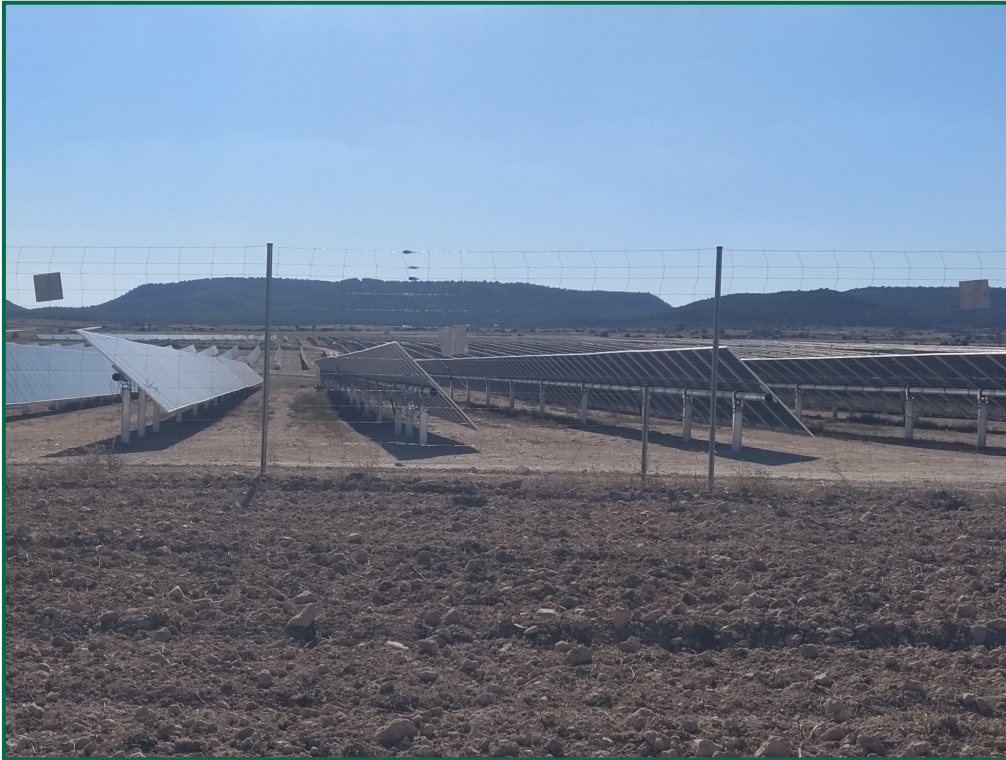
Fotografía 11. Vallado perimetral con placas anticollisión.
