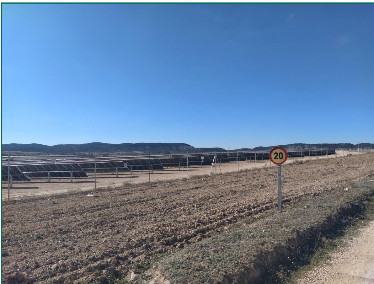
Fotografía 3. Señal de limitación de velocidad.
