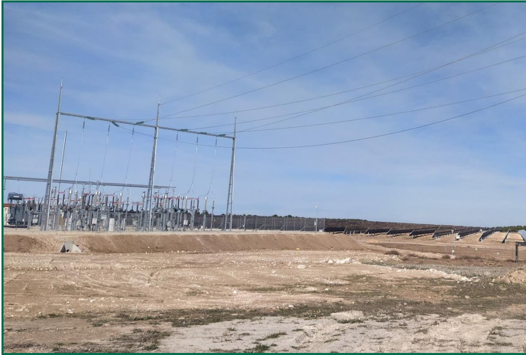
Fotografía 4. Tierra vegetal sobre talud.
