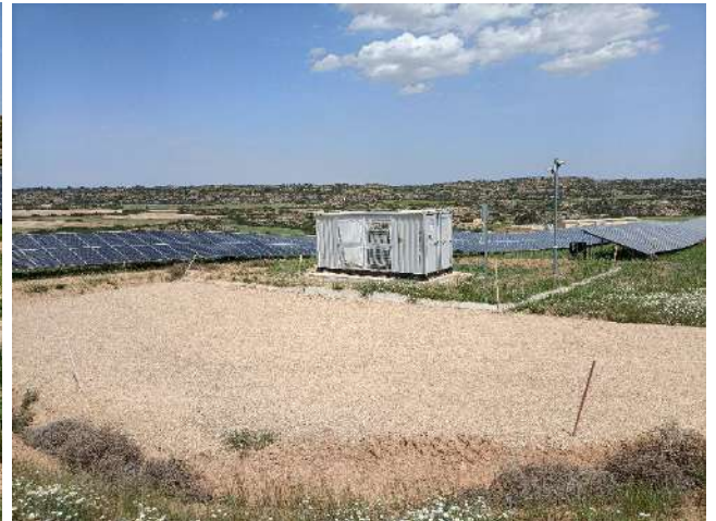
Figura 58. Zona de ubicación del CT5 (sin derrames)
