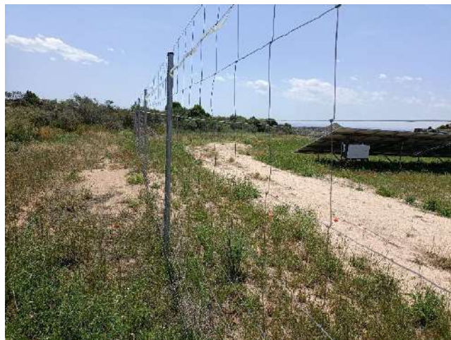
Figura 22: Fuera de vallado zona perimetral (18-05-22)
