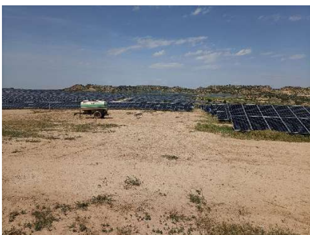
Figura 7. Dentro de vallado en zona perimetral
