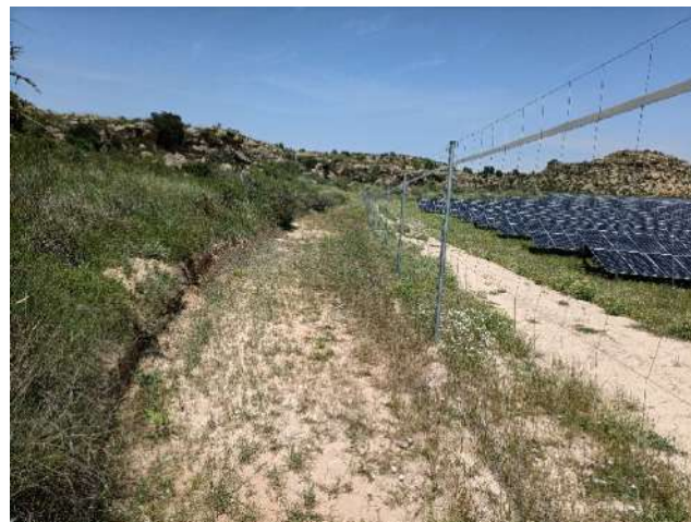
Figura 19. Fuera del vallado zona perimetral (18-05-22)
