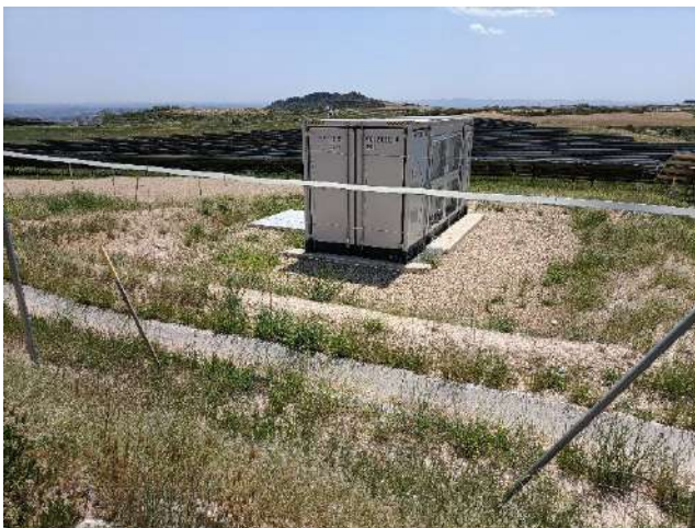
Figura 11: Cuneta interior perimetral de pluviales
