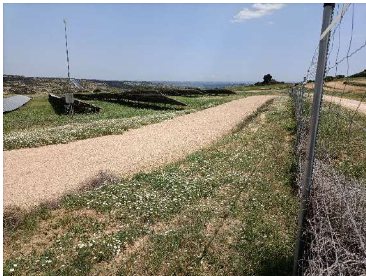
Figura 56. Vial interior perimetral en buen estado
