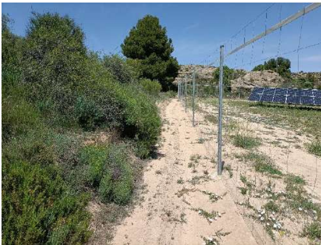
Figura 17. Fuera del vallado zona perimetral (18-05-22)
