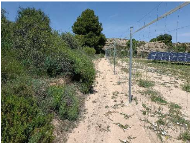
Figura 42. Franja perimetral del vallado (buen estado)
