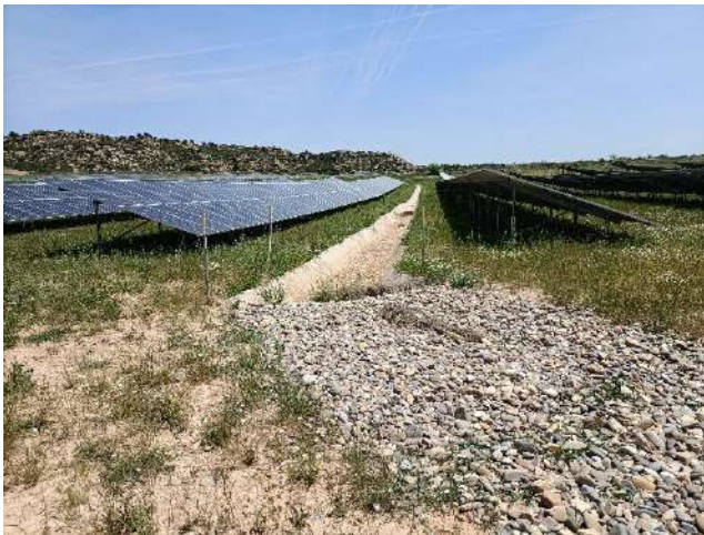
Figura 9: Salida de cuneta interior de pluviales
