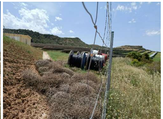
Figura 16: Cuneta interior con vegetación rodante
