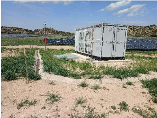
Figura 57. Zona de ubicación del CT4 (sin derrames)
