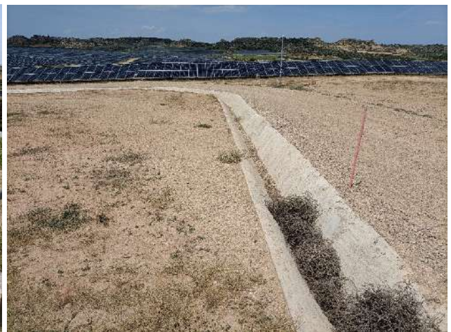
Figura 12: Cuneta de pluviales en vial interior
