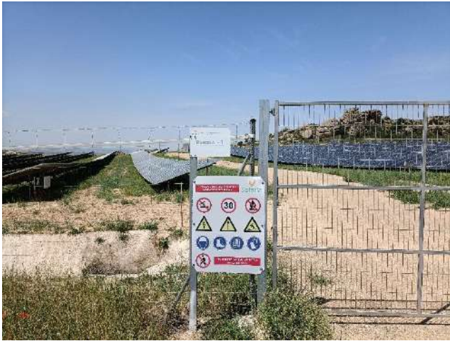
Figura 29 . Puerta Parcela 1 de la Planta (18-05-22)
