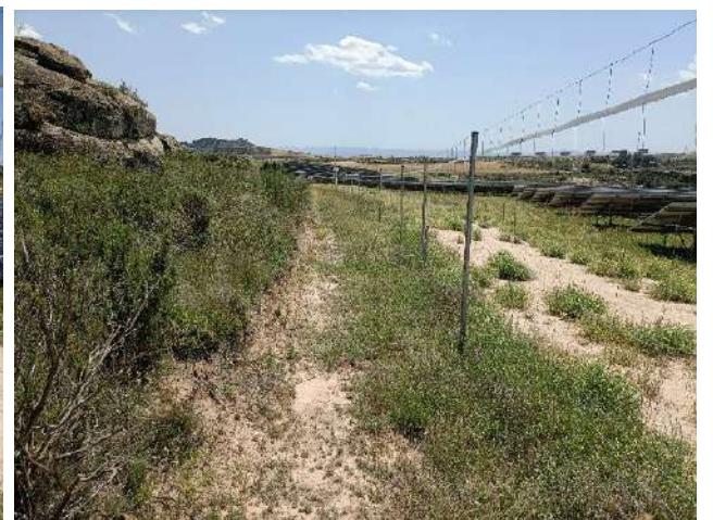
Figura 20. Fuera vallado zona perimetral (18-05-22)
