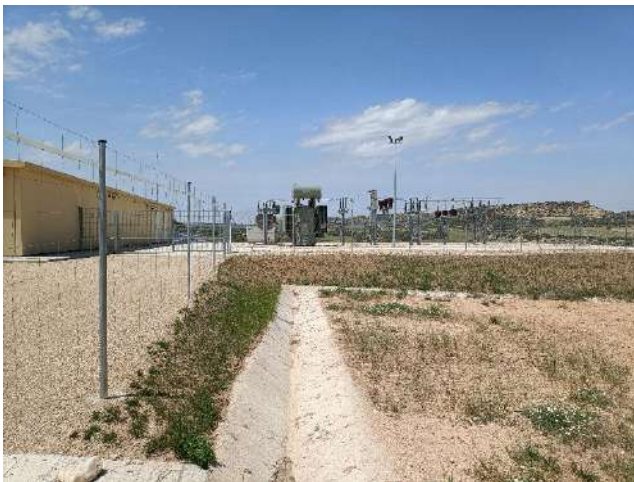
Figura 15: Cuneta interior pluviales (zona SET)
