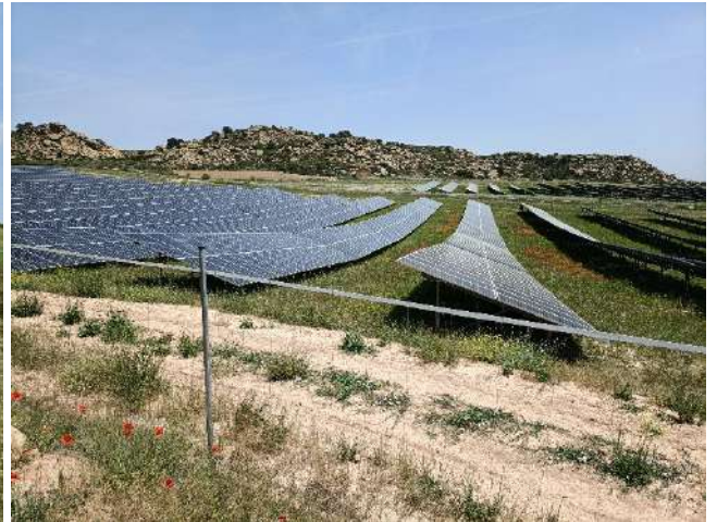
Figura 52. Inspección del fleje (buen estado)
