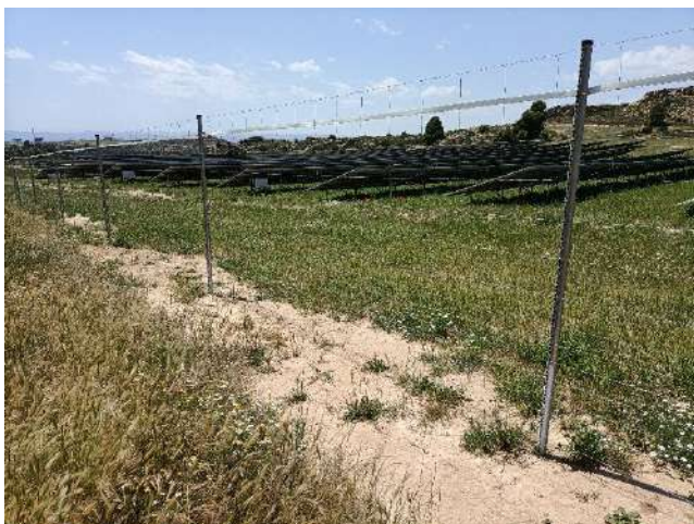
Figura 21. Fuera de vallado zona perimetral (18-05-22)
