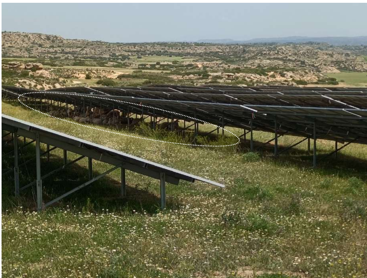
Figura 50. Presencia de ganado (en blanco discontinuo) en zona todavía no desbrozada (Fecha: 18/05/2022)
