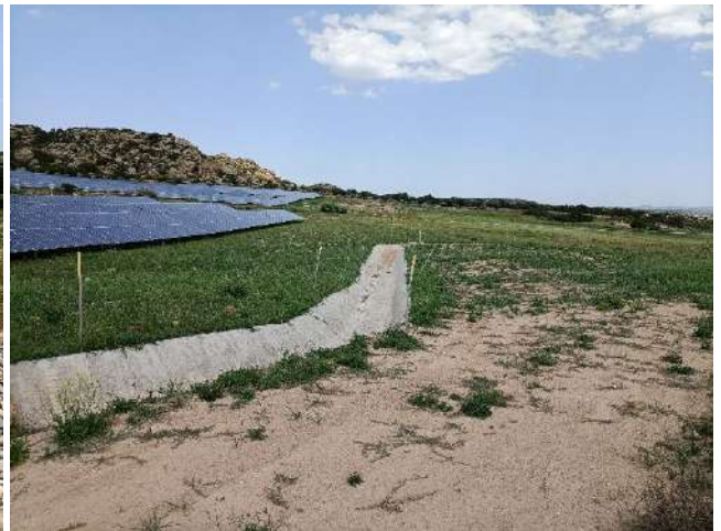
Figura 10: Cuneta interior recogida de aguas pluviales
