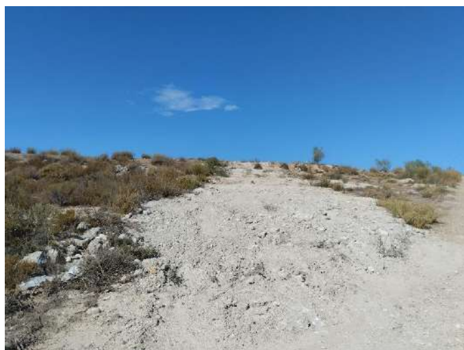
Estado final de la zanja en sectores en los que discurre por terreno con vegetación natural.
