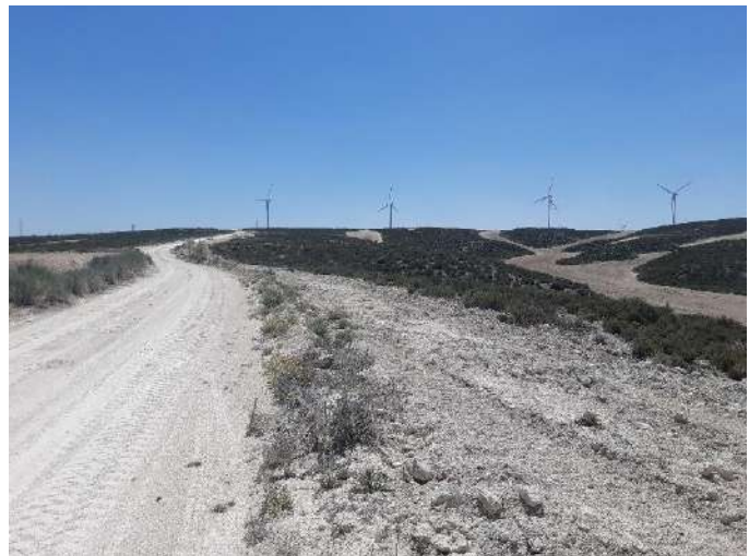
Recolocado correcto del balizado de a zanja y estado final tras el tapado y restitución morfológica.
