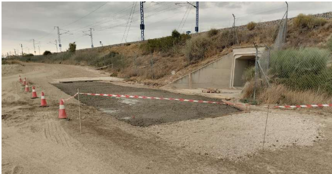
Ejecución de vado en el cruce de camino sobre el barranco de Val de las Vacas.
