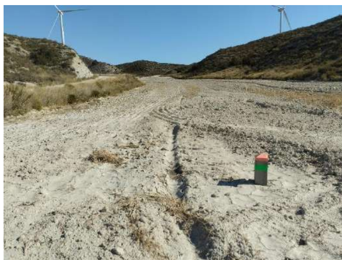
Estado final de la zanja en sectores en los que discurre por campos de cultivo.
