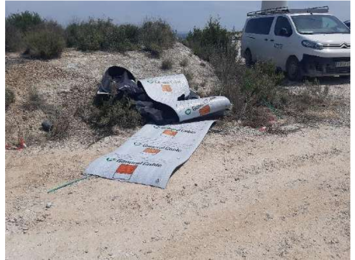
Pequeñas incorrecciones detectadas en la ejecución de la zanja: balizado incorrecto y restos sin retirar
