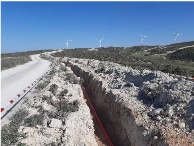
Recolocado correcto del balizado de a zanja y estado final tras el tapado y restitución morfológica.
