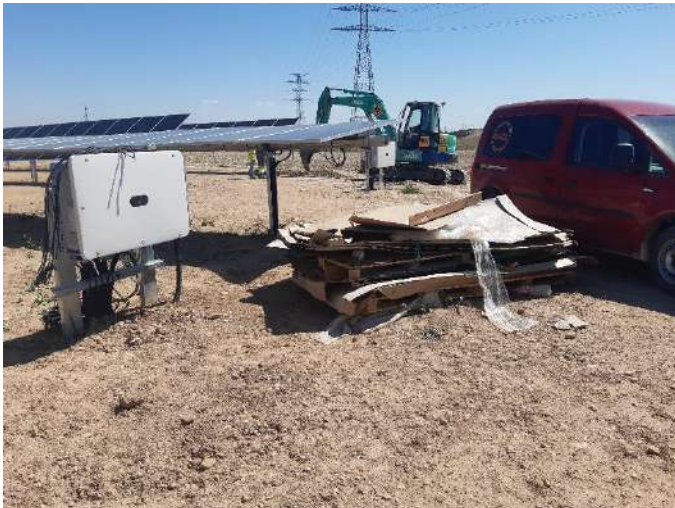
Acumulación indebida de restos de embalajes en las parcelas de la PSFV y retirada de los mismos al punto limpio
