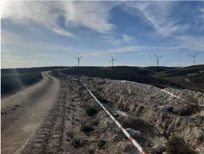
Pequeñas incorrecciones detectadas en la ejecución de la zanja: balizado incorrecto y restos sin retirar
