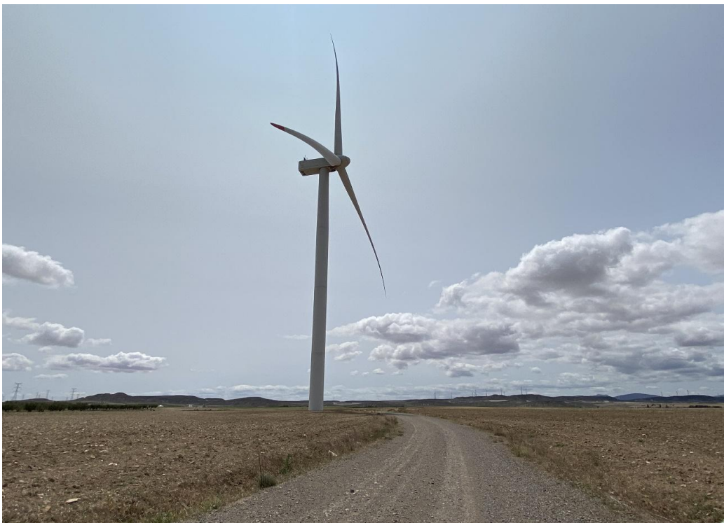
Figura 10: Vial perteneciente al Aerogenerador TIN-07.
