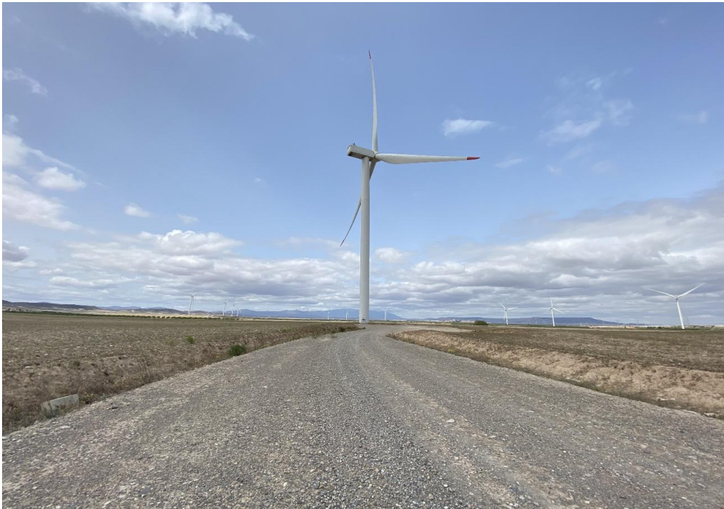
Figura 9: Vial perteneciente al Aerogenerador TIN-05.
