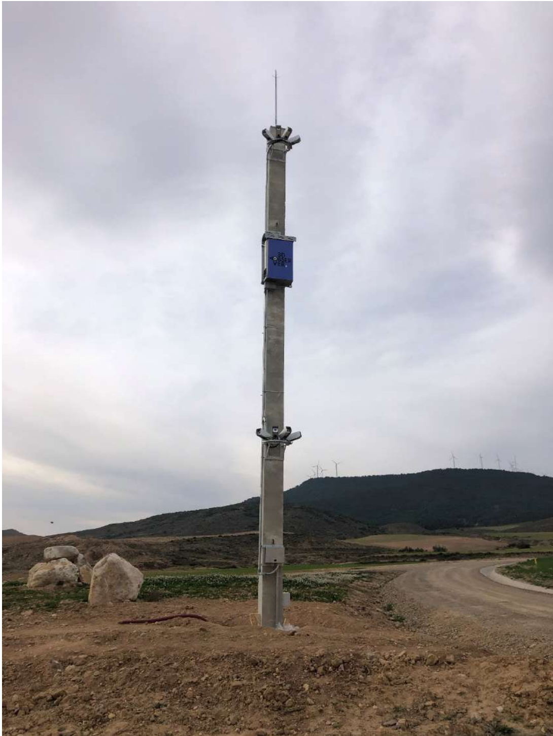
Imagen 8. Vista del 3dobsever 2 ya instalado.
