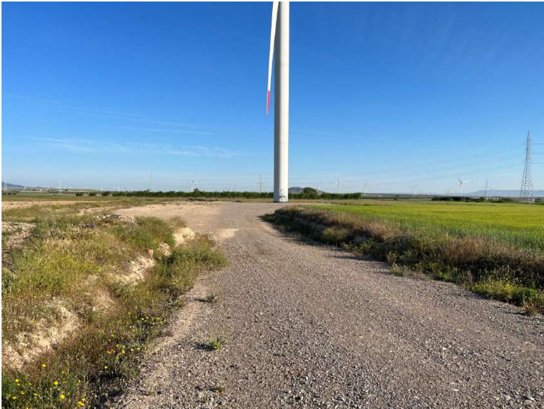
Imagen 15. Estado del talud anexo a la plataforma aerogenerador 4.
