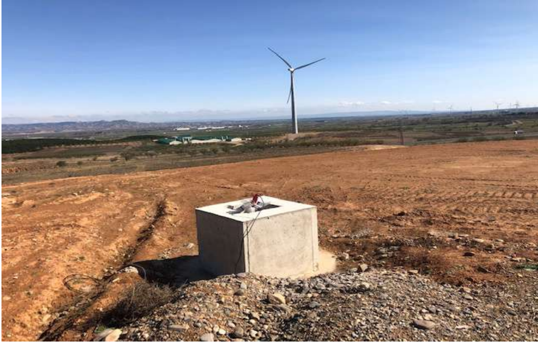
Imagen 5. Vista del encofrado del 3dobserver y tubos de energía y fibra.
