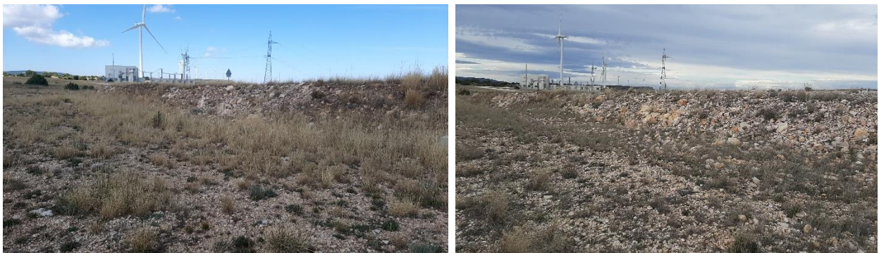
Comparativa del talud sur de SO-04 entre el cuatrimestre anterior (izq.) y el cuatrimestre actual (dcha.).
