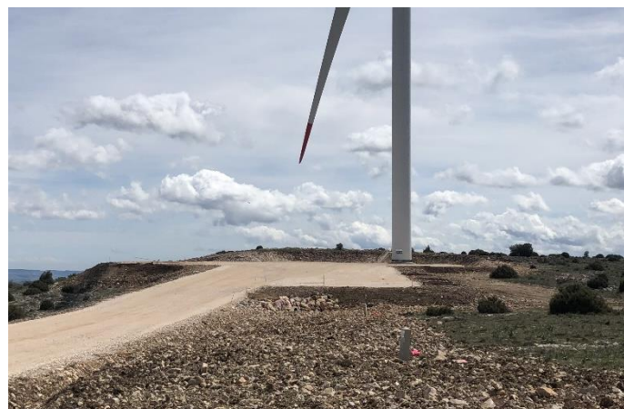
Detalle del aerogenerador con pintado de palas en la punta.
