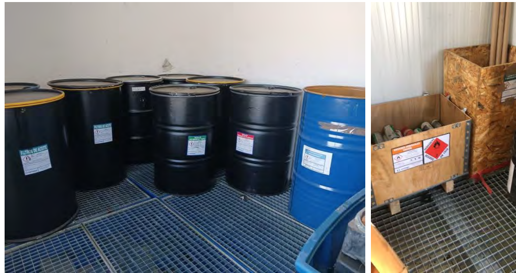
Fotografías 17 y 18: Interior almacén residuos, colocados sobre rejilla
