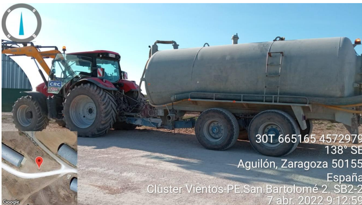
Imagen 3. Cuba de agua disponible en obra para ejecutar riegos en viales.
